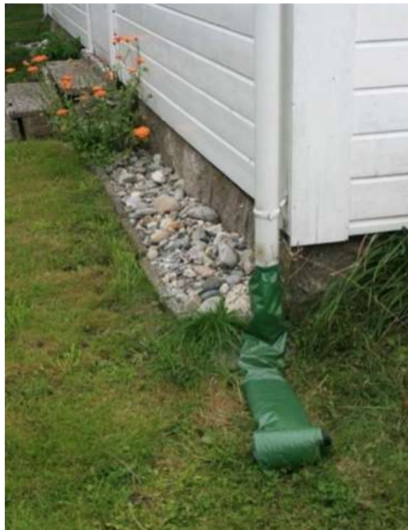
Figur 2-13: Frakobling av takvann (arkitektur.no).
