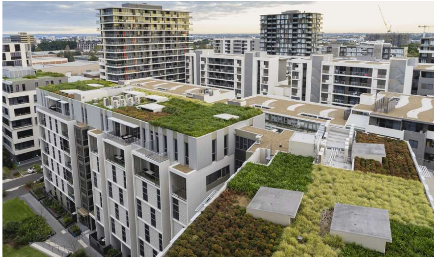
Figur 2-16: Grønne tak i tettsted (Grønn overvannshåndtering, 2017).
