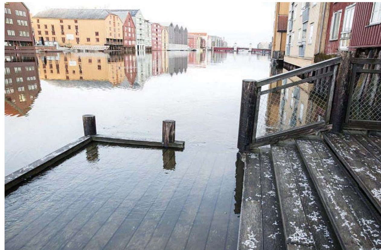
Figur 5.1: stormflohendelse i Trondheim januar 2017. Bryggerekkene er utsatt for oversvømmelse ved økt vannstand som følge av lavtrykk kombinert med pålandsvind. Økt nedbør og avrenning kan også bidra til slike oversvømmelser.
