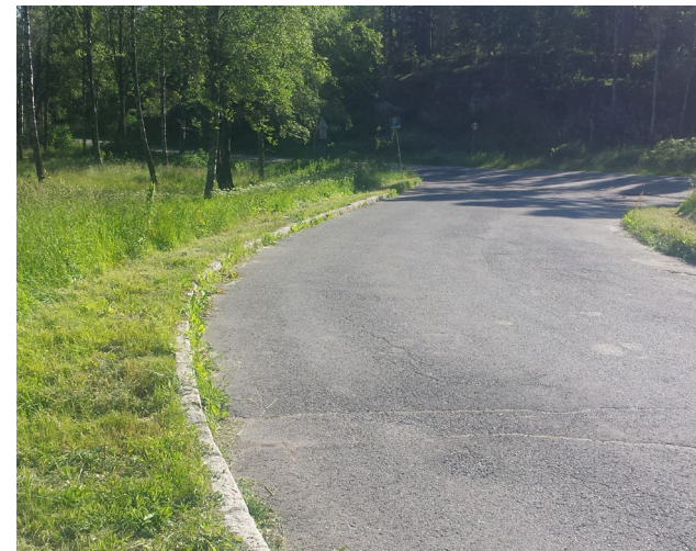
Bildet over, viser hvordan engen ser ut etter klipping langs med kanten av veien og overgangen til skogen.
