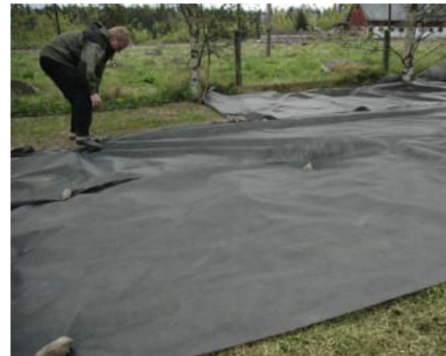
Figur 3.7 og 3.8: Sødre Småland, mai. 2006 Utlegging av duk over område med klippet gress og skvallerkål. Etterpå ble 5-8 cm jord lagt over. Bildet under er fra august 2006, og en kan se at engartene allerede har begynt å vokse. Foto: Pratensis AB
