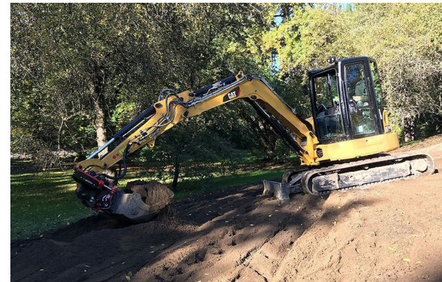
Figur 3.14: Botanisk Hage, 2012. Gjering av gressmatte og tilførsel av grus med gravemaskin.
