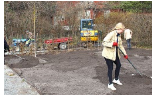
Figur 3.11: Ultuna, SLU Uppsala. Gresset hadde blitt fjernet med gravemaskin, Ny jord legges med grus på toppen. Engfrøblanding ble sådd tilslutt. Foto: M. Ignatieva.
