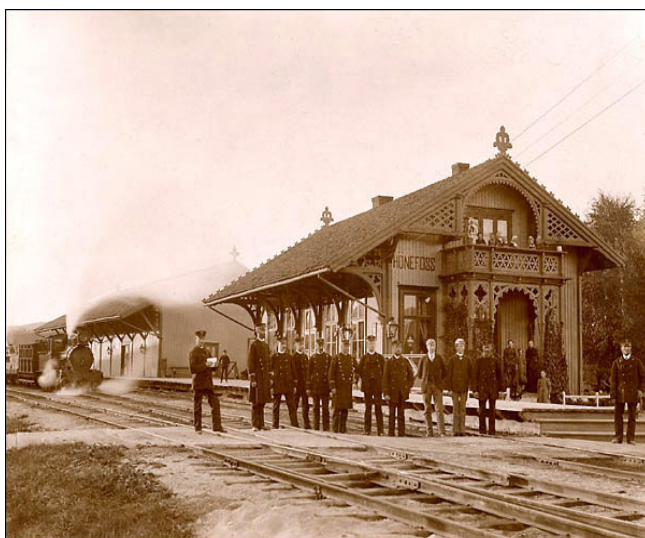
Figur 7: Hønefoss stasjon i 1896. I dag er denne stasjonsbygningen revet.
