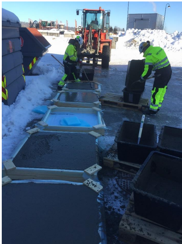
Bilde 26: Fylling av betong i forskalingsformer.
