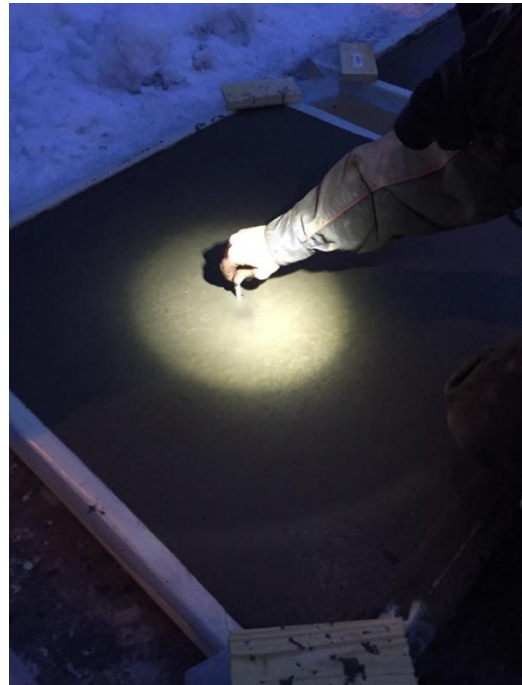
Bilde 21b: Sjekk av inntrengningsdybde med bolt.
