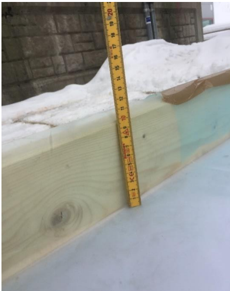
Bilde 18a: 100 mm forskalingsramme for dekkestøp.
