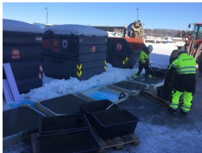
Bilde 19: Betong fylles i forskalingsrammene.
