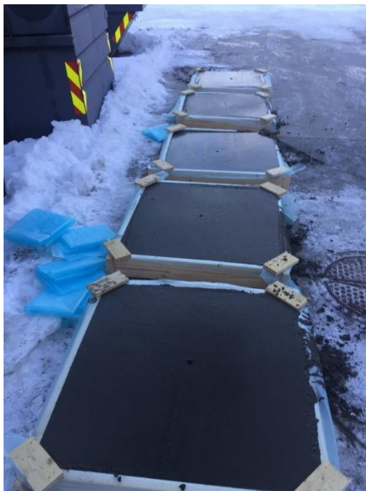
Bilde 20: Ferdig utstøpte dekker.
