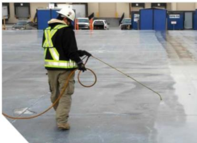
Bilde 9: Påføring av herdemembran. Hentet fra (Haucon Norge AS 2016).
