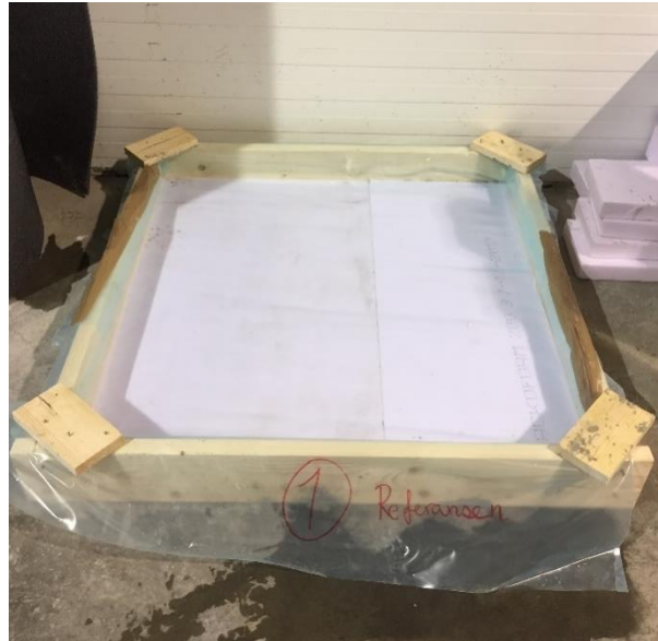
Bilde 18b: Forskalingsramme til dekkestøp.
