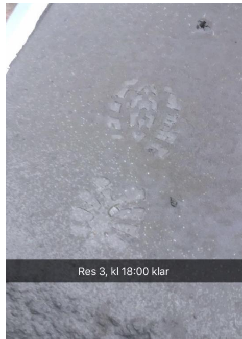
Bilde 27b: Fotavtrykk ved glattetidspunkt.
