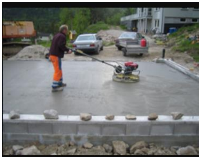
Bilde 6: Glatting av betonggulv. Hentet fra (Unicon 2017).
