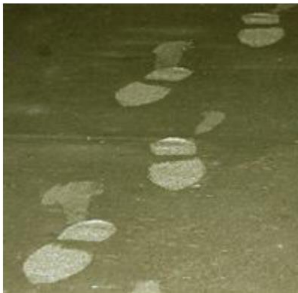
Bilde 7: Fotavtrykk i betong som er klar for glatting. Hentet fra (Norsk Betongforening 2017).
