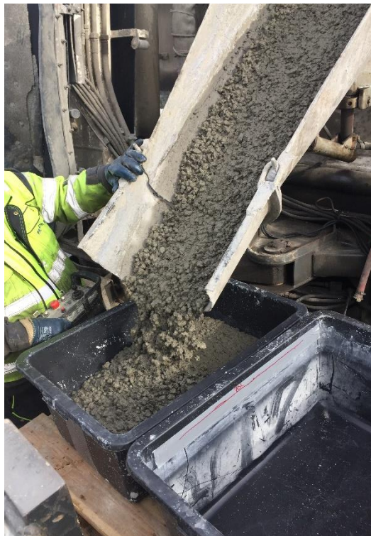
Bilde 23: Fylling av betong i murdunker.
