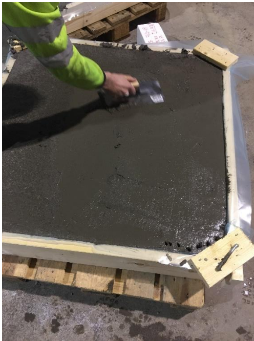
Bilde 27a: Glatting med stålglatter.
