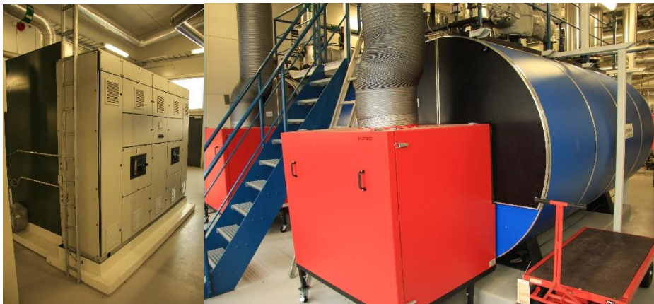
Figur 15: El-kjel og oljekjel
