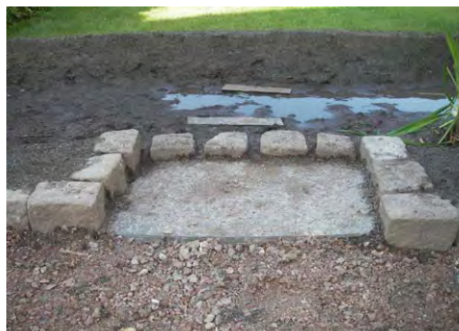
Figur 3-25: Innløp utformet med lave åpne kantsteiner. (Braskerud et al. 2013).
