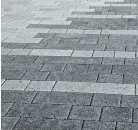
Figur 4-5: Ganghelle Dren er en belegningsstein i betong som i fargen grå og koks som gir mulighet til å legge spennende mønster. (multiblokk.no)
