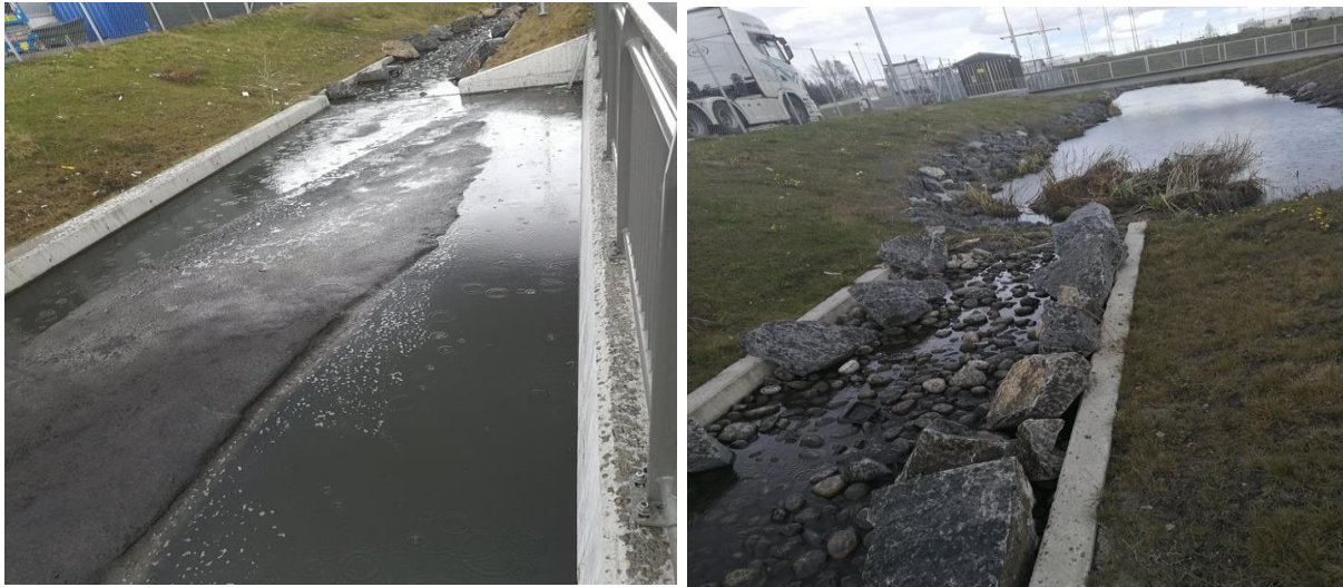
Figur 4.13: Bilder av rensedammen oppstrøms og nedstrøms V-overløpet. Bildet til venstre viser bassenget oppstrøms. Det inneholder fortsatt mye is. Det er tydelig at vannet inneholder en del grums og partikler. Bildet til høyre viser bassenget nedstrøms V-overløpet. Det befinner seg noe vann i rensedammen.
