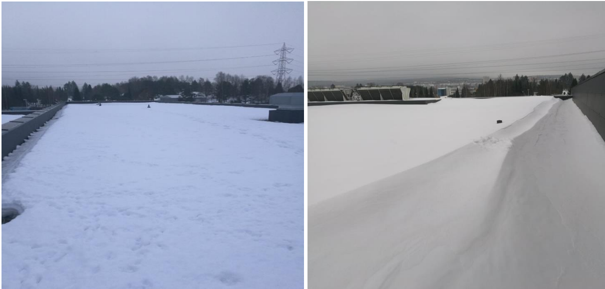
Figur 4.16: Snømengder på det grønne taket. Bildet til venstre er fra befaring den 26. januar av den midterste delen. Snøen har mistet sin høyde på grunn av større mengder vann i snøen. Bildet til høyre er tatt den 7. mars av delen til høyre. Her har det lagt seg et lag med pudder på toppen av skaren. Bildet viser hvordan snøen fordeler seg langs kanten.
