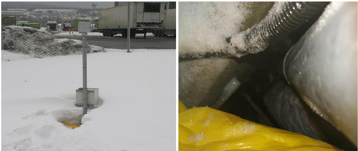
Figur 4.8: Bilder tatt fra befaring den 7. mars. Bildet til venstre viser nedbørmåleren. Bildet til høyre viser hvordan det så ut nede i magasinet foran V-overløpet. Det ble observert små mengder med snø og at deler av vannet hadde fryst. På grunn av de store snømengdene rundt løsningen ble det vanskelig å undersøke vannmengdene i magasinet.
