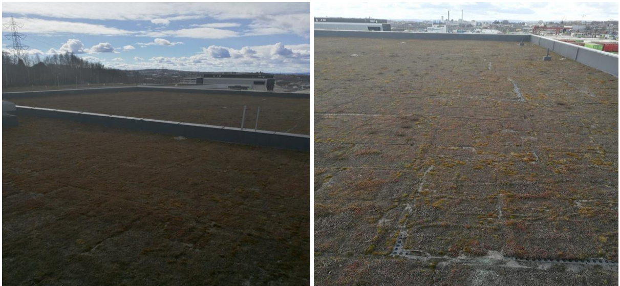
Figur 4.18: Det grønne taket den 25. april 2018. Taket var snøfritt. Bildet til venstre viser den midterste og den venstre delen av det grønne taket. Bildet til høyre viser at noen av sedummattene ikke var heldekket. Det grønne taket hadde en brungrønn farge.
