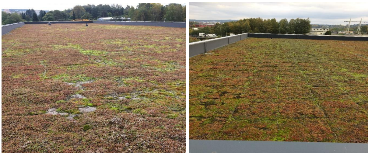
Figur 3.3: Bilder av det grønne taket på Bring Stasjon termoterminal B1 september 2017.
