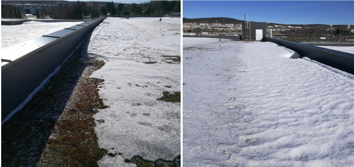
Figur 4.17: Bilder av det grønne taket 6. april 2018. Deler av det grønne taket var uten snø (bildet til venstre). Det var mer snø i kantene enn i midten av taket (bildet til høyre). Bildet er tatt av den midterste delen.
