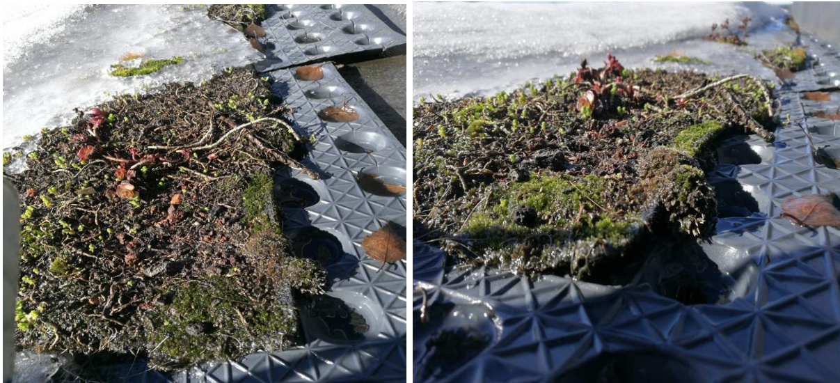
Figur 3.4: Bilder av oppbygningen til det grønne taket tatt den 6. april 2018. Taket er bygget opp med sedum på toppen, etterfulgt av en filtmatte og en dreneringsplate med knaster vendt oppover.
