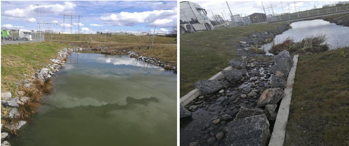
Figur 3.2: Bildet av rensedammene på tomtens sørside. Rensedammene skal fange opp sedimentering før det føres videre til Alnaelva. Bildene er tatt 15. april 2018.
