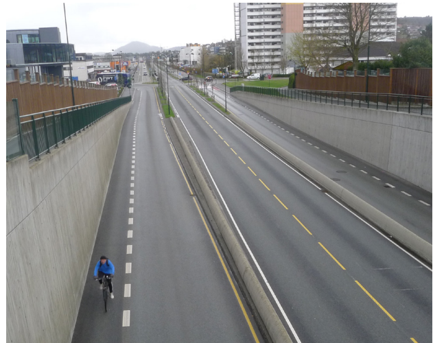
Figur 14: Fotografiet viser sykkelløsningen langs den nye bussveien mellom Stavanger og Sandnes.
