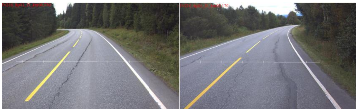
Figur 3-7: Strekningene t.h. og t.v. har begge havnet i skadeklasse SK4 [ViaPhoto]
