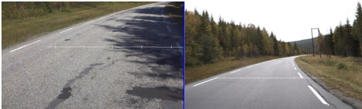
Figur 4-4: Telesprekkene (noen litt bortgjemt i skyggen) fra 2010 er i 2017 forskjøvet til høyre kant [ViaPhoto]
