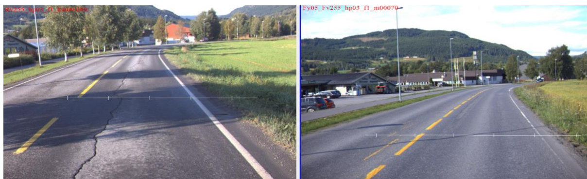
Figur 4-2: Samme strekning like før med tydelig effekt av asfaltarmeringen [ViaPhoto]
