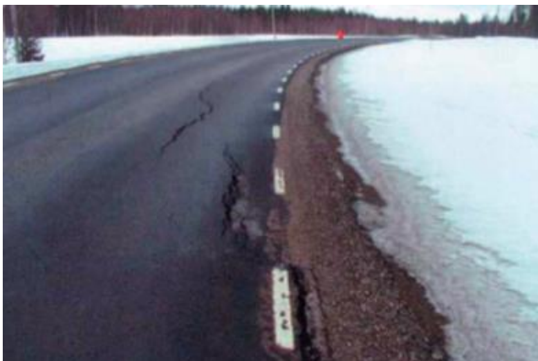
Figur 2-13: Prøvestrekningen fra nord-Sverige med en del med armering og en uten[12]
