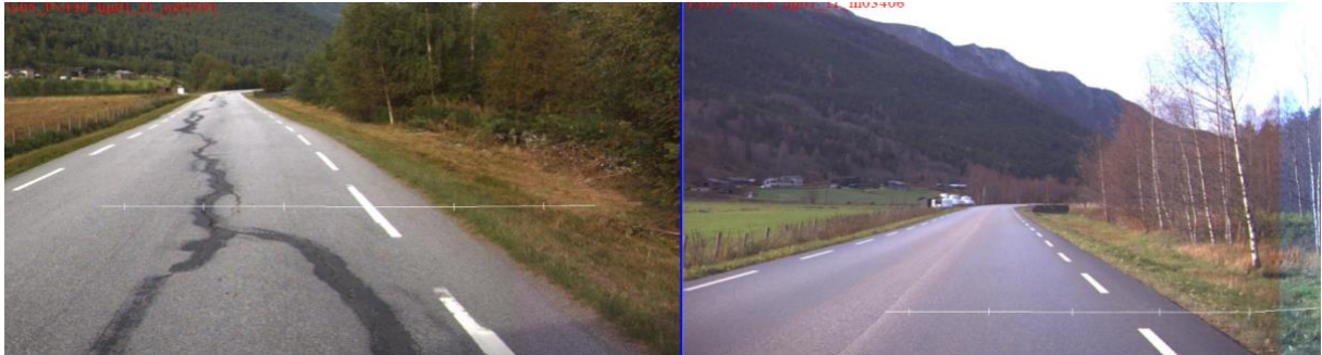
Figur 4-9: Bildet t.v. viser store injiserte telesprekker som i 2017(t-h.) ikke er oppdaget på nytt [ViaPhoto]
