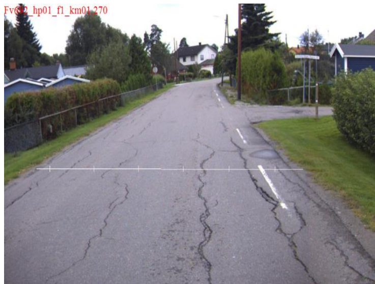
Figur 3-6: : Strekning som er klassifisert til skadeklasse SK3 [ViaPhoto]
