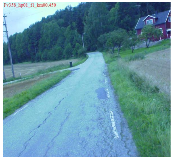
Figur 3-5: Strekning klassifiseres til skadeklasse SK2 [ViaPhoto]
