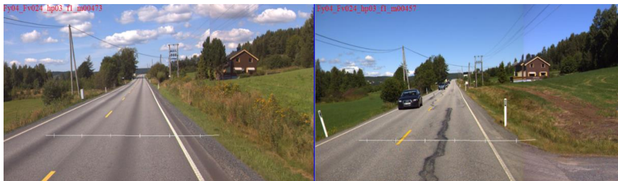
Figur 4-11: T.v er vegen uten telesprekker i 2012, t.h. er det oppstått nye store telesprekker i 2017 [ViaPhoto]
