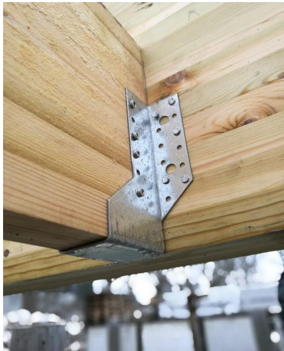
Figur 7.33 Bjelkesko for innfesting av last-bjelmene
