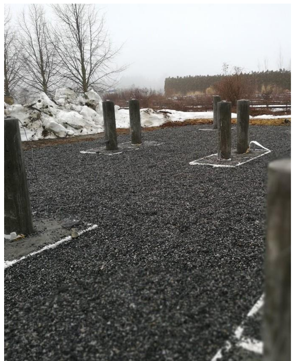
Figur 7.30 Området gjenfylt og fundamentsøylene på plass
