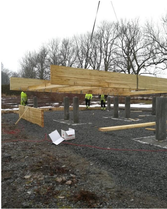
Figur 7.35 Hovedbjelkene løftes på fundamentsøylene
