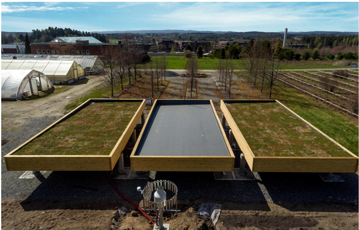
Figur 8.2 Bia sett mot veterinærbygget. Foto: S. Nyborg
