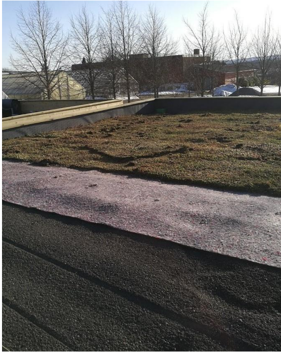
Figur 7.46 Filt og sedum rullet utover finknust LECA
