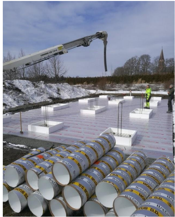
Figur 7.28 Forskalinger til søylefundamentet
