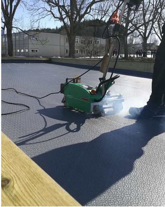
Figur 7.40 Overlappene ble skjøtet sammen med varmluft
