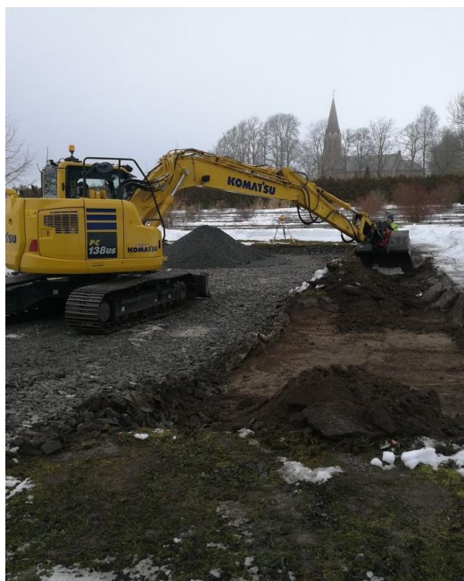
Figur 7.25 Grunnmassene på forsøksområdet
