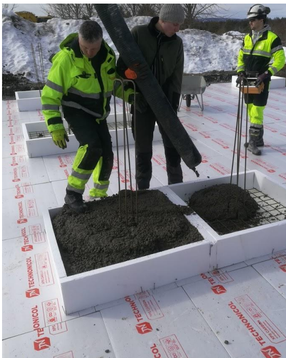
Figur 7.31 Forskalingene som fylles med betong
