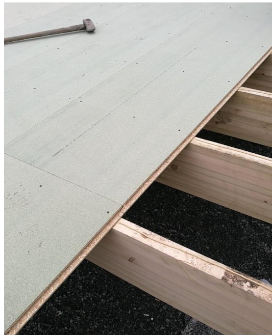
Figur 7.36 Sponplatene brukt som toppdekke
