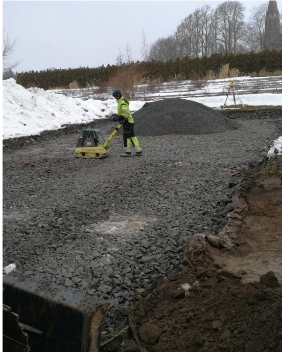
Figur 7.27 Grunnmassene som blir komprimert
