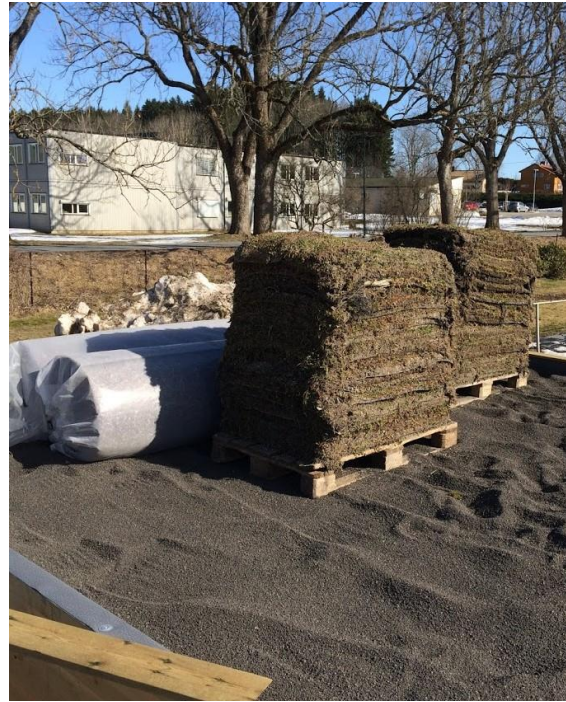
Figur 7.45 Sedum og filt løftet på taket
