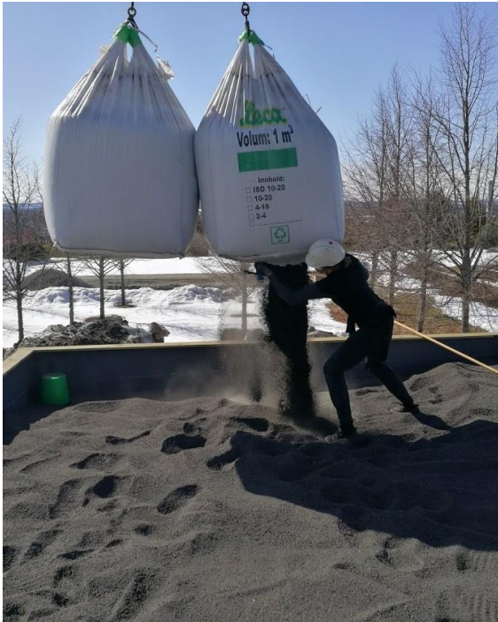
Figur 7.44 LECA-materialet ble fordelt utover taket
