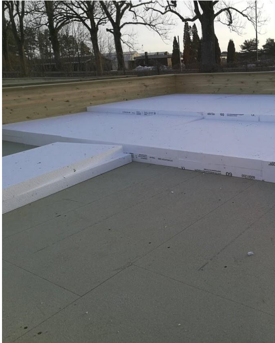
Figur 7.39 Isolasjonsplater for falloppbygging
