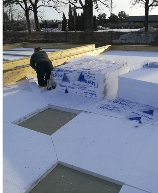
Figur 7.38 Fallplatene tilpasset takets form
