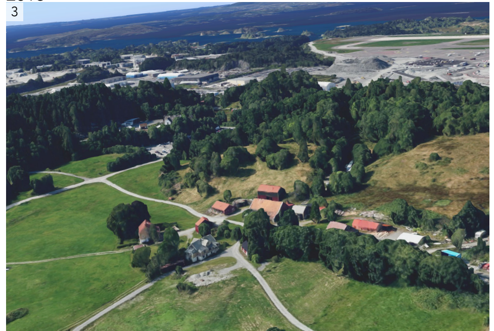
Figur 1.21: Lokasjon for bildet er vist på flybildet fra 1951 (se figur 1.17). Landskapet har gjennomgått store endringer siden 1955. Det er etablert store næringsområder (del av Espehaugen og Lønningen) til venstre i bildet, som virker dominerende i landskapet. Flyplassarealene er utvidet siden 1955, og til høyre i bakkant av bildet vises utbyggingen av terminal T3. Landskapet er også preget av økt trevegetasjon ved gården som følge av mindre beiting. Trevegetasjonen skaper en visuell buffer mellom gården og flyplassområdet. Selve gårdstunet fremstår i stor grad som i 1955. Foto: Google Earth
