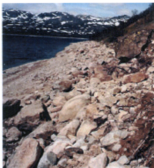
Bilde 5. Strandsonen er steinsatt opp til nivået for høy vannstand. Ras langs vannkanten førte til at steiner rullet lenger ned. Reguleringen har trolig gjemt denne beskyttelsen. Bunnmorene her har relativt lite stein, det er en årsak til at rasene ikke har reparert seg selv. Steinfattig grunn øker muligheten undergraving. Med varierende vannstand blir det stor høydeforskjell i bølgenes brenningssone. Ved steinsetting er det vanskelig å plassere det begrensa materialet ideelt.
