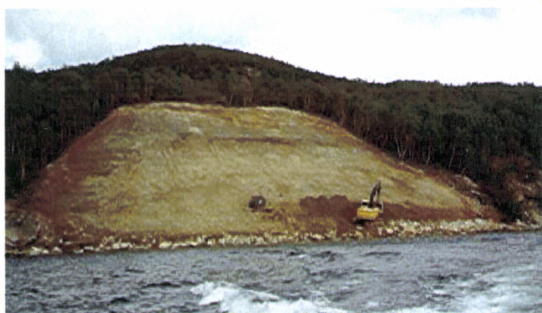
Bilde 4. Samme felt etter planering høsten -97. Det foregår steinsetting med gravemaskin i strandsonen for høy vannstand. Stort sett var det for lite stein til at steinsettingen ble så omfattende som ønskelig. Bildet tatt ved høy vannstand.
