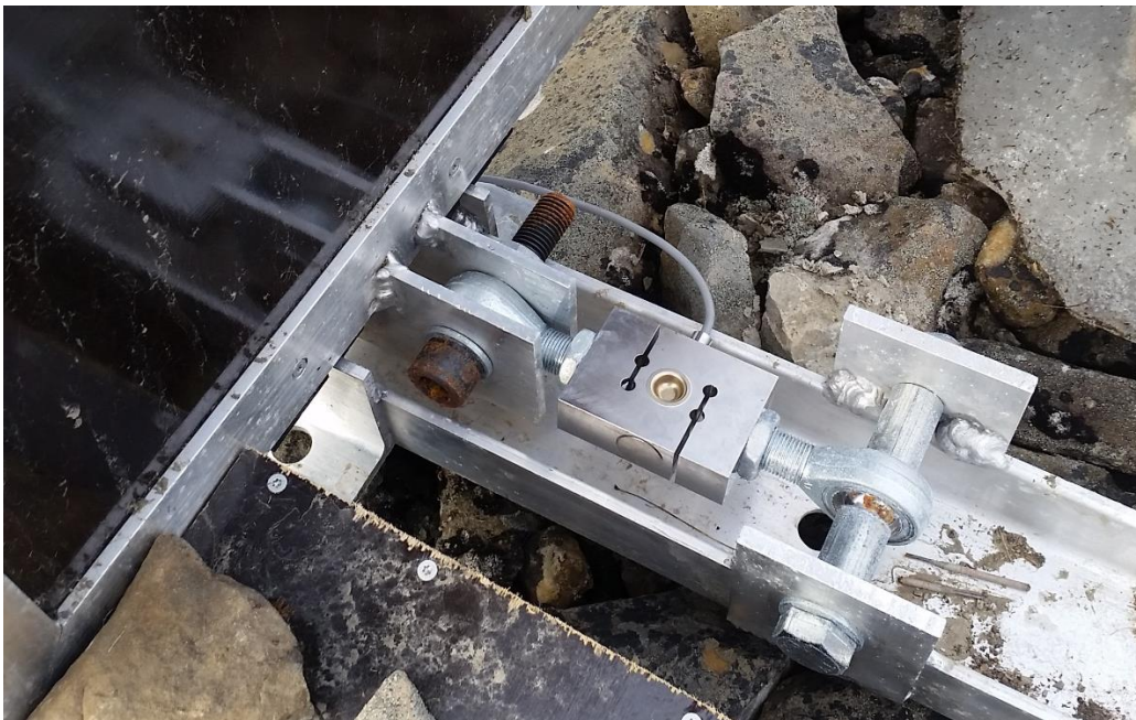
Figur 24: HBM S9M-lastcelle montert i strekk i underkant av forsøksveggen. Foto: Jan Are Jacobsen.
