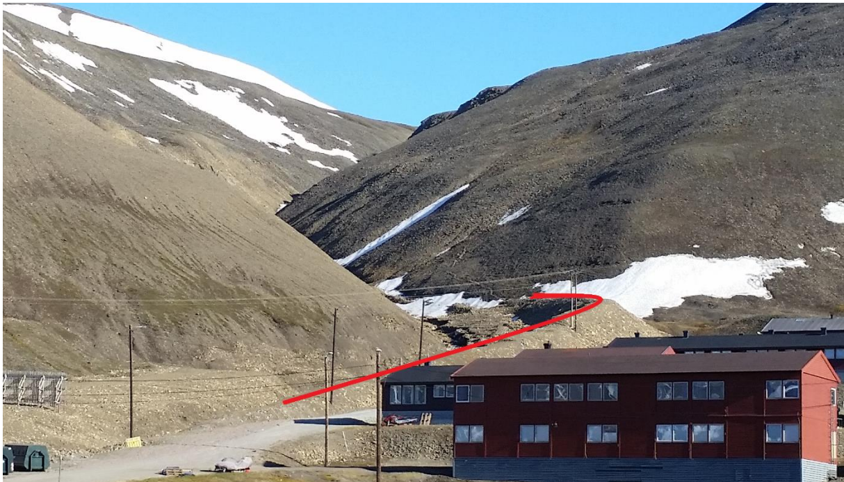
Figur 8: Ledevoll for å beskytte de nord-østligste boligene på Haugen i Longyearbyen (merket med rødt). Foto: Jan Are Jacobsen.
