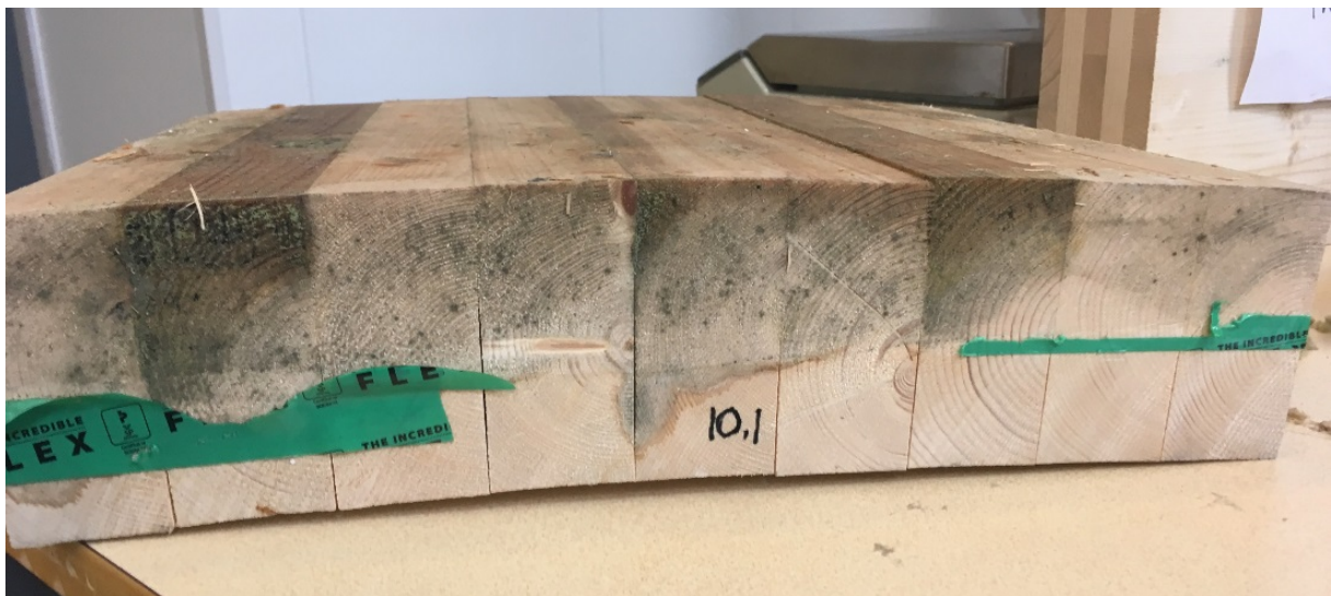
Figur 64: Kuving av kantstilt element. Bildet viser i tillegg soppangrep nedover på lamellene.
