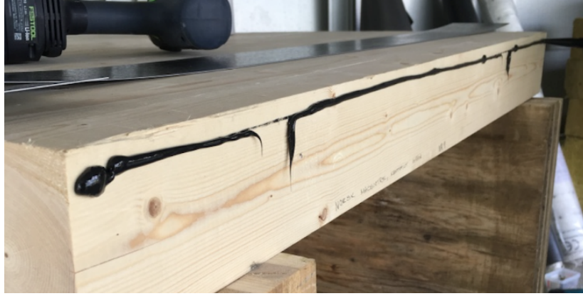
Figur 63: Påføring av fugemasse mellom massivtre og beslag.
