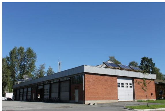
Energilaboratoriet ved UMB (foto: Snorre Nordal).
