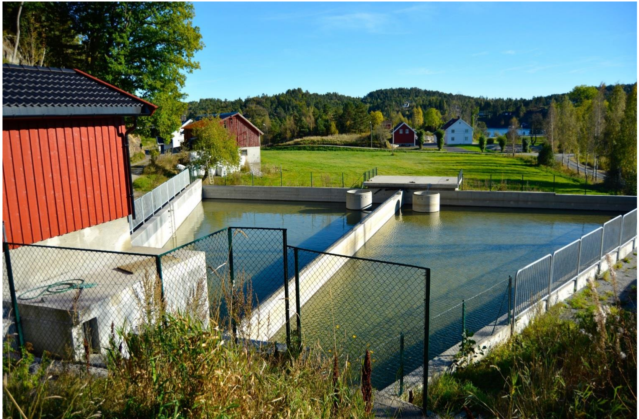
Figur 1. Renseanlegget i Stordalsbekken, her lut-behandles vannet før det slippes ut i bekk- og fjordsystemet. Foto: Hanne Johansen
