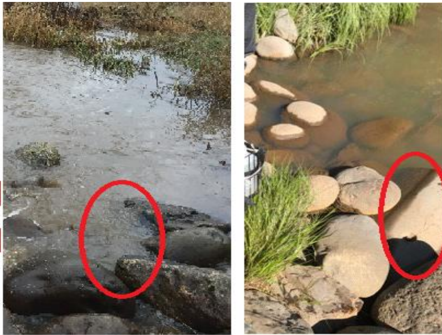
Figur 5. 5 viser hvordan er vannet nivået har dekket helt rør ra terksl 1 , til venstre ved høy nedbør til venstre ved nedbørmengde. Foto Asil Abudayya.
