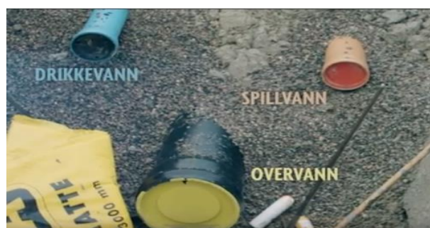
Figur 2. 1 viser grøften med de tre vannledninger.
