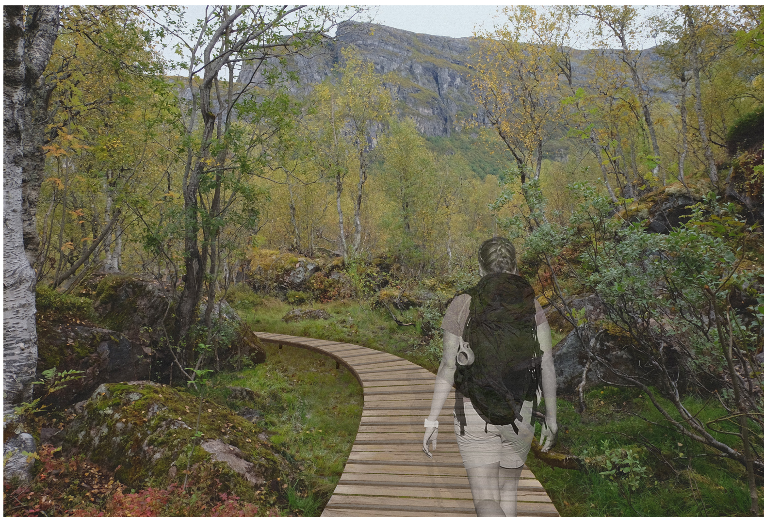
Fig. 90 Ny klopplegging som heves over vegetasjonen, vil kunne skåne vegetasjonen og gir mulighet til gjenvekst. Dette er både økologisk og estetisk positivt, og kan være med å heve opplevelseskvaliteten til de besøkende. Klopplegging gjør det også lettere at de besøkende holder seg til stien.
