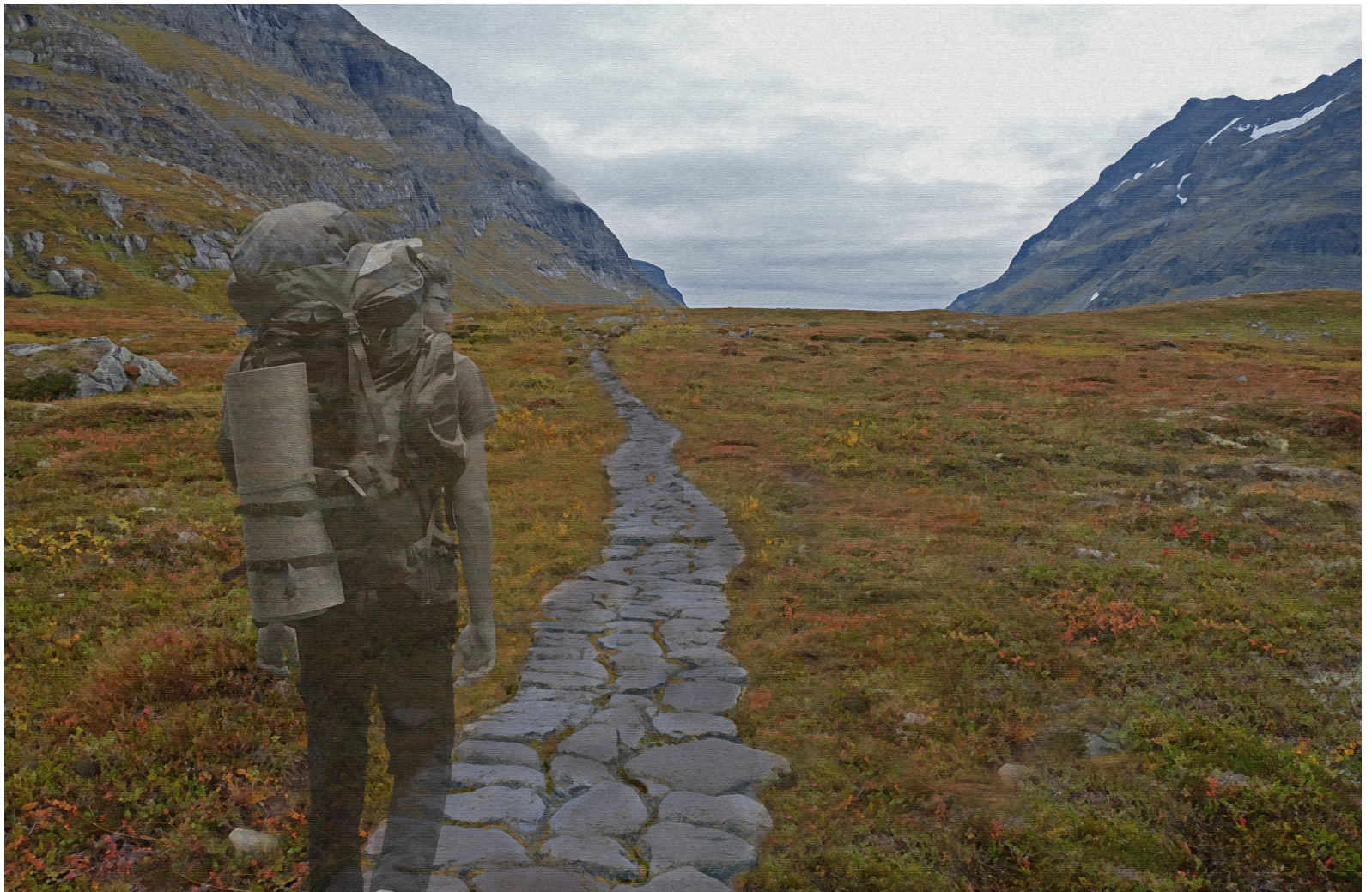
Fig. 92 Illustrasjonen viser hvordan hellelegging med naturstein kan løses på stier med stor slitasje. Formålet er å styre ferdselen på stien slik at øvrig vegetasjon skånes fra slitasje. Bruk av naturstein fra området vil gjøre at den hellelagte stien harmonerer med omgivelsene.
