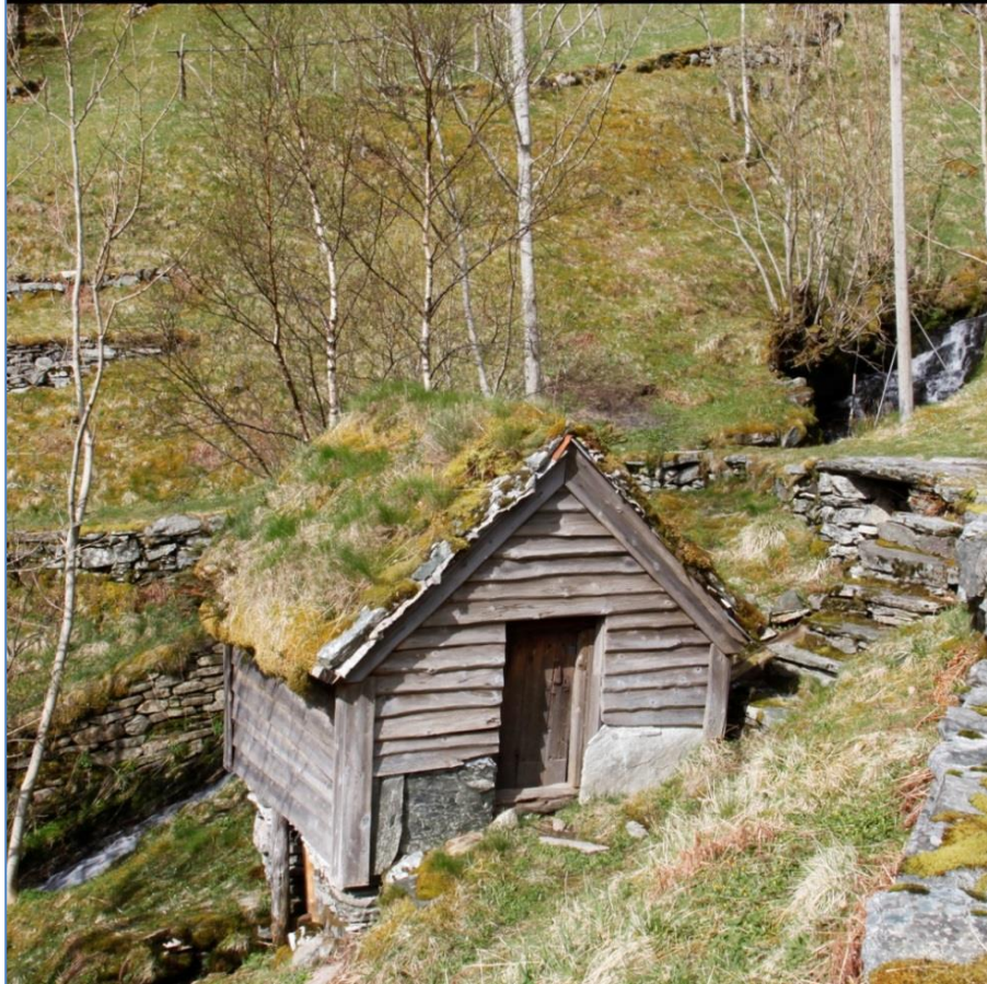
1958 ca.: Nyrestaurert kvernhus med bølgeblekketak på bruk nr. 4, Semenskvednhuset. Foto: Johannes Torp (priv.).
