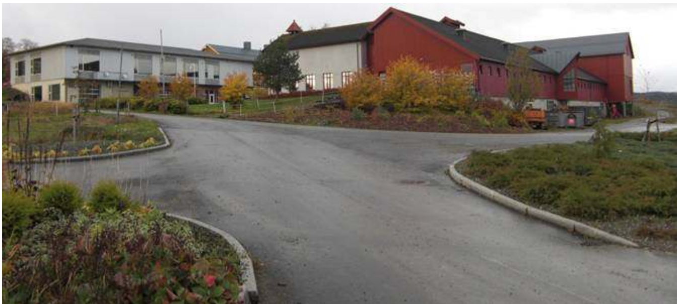
Figur 4.1 Storfjøset på Mære landbruksskole (rød bygning til høyre).
