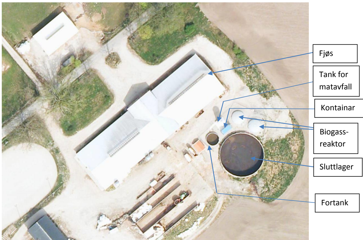
Figur 1. oversiktsbilete av biogassanlegget på Tomb VGS. Kjelde: http://kart.gulesider.no
