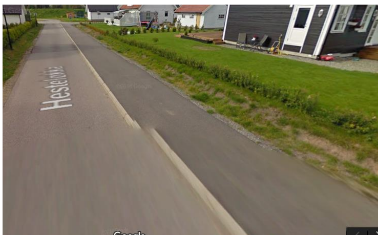
Figur 27: Eksempel på en grøft som har infiltrasjons funksjon (utklipp fra googles maps).
