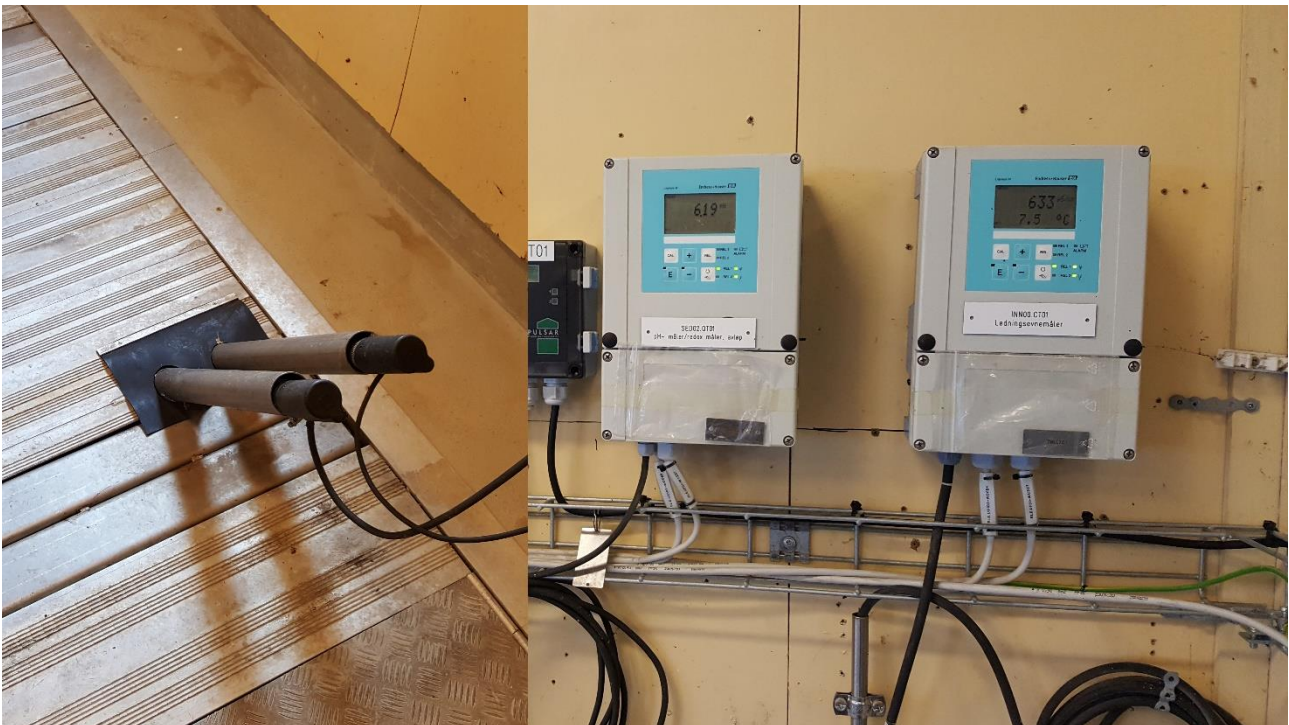
Figur 3-6 Sensorer for pH, turbiditet og temperatur til venstre. Kontrollbokser til høyre. Foto: Andreas Lindhjem
