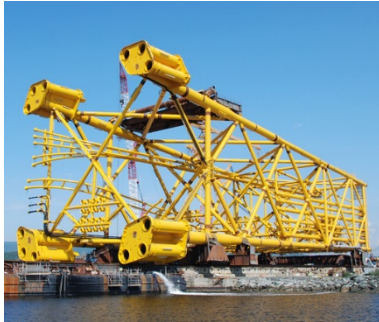
Figur 2-5: Jacketkonstruksjon fra Kværner ASA [14].
