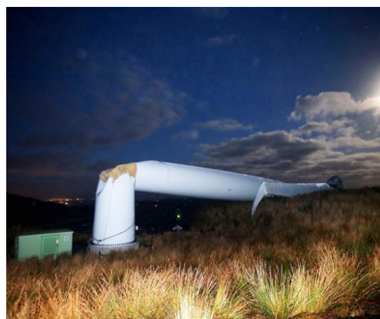
Figur 2-4: Global knekking av vindmølletårn som kan ha startet med lokal knekking og videre en rask kollaps av strukturen [12].
