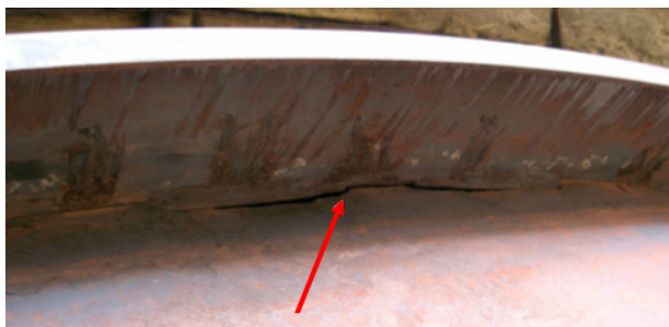
Figur 2-9: Sprekk ved ringstiver [20].
