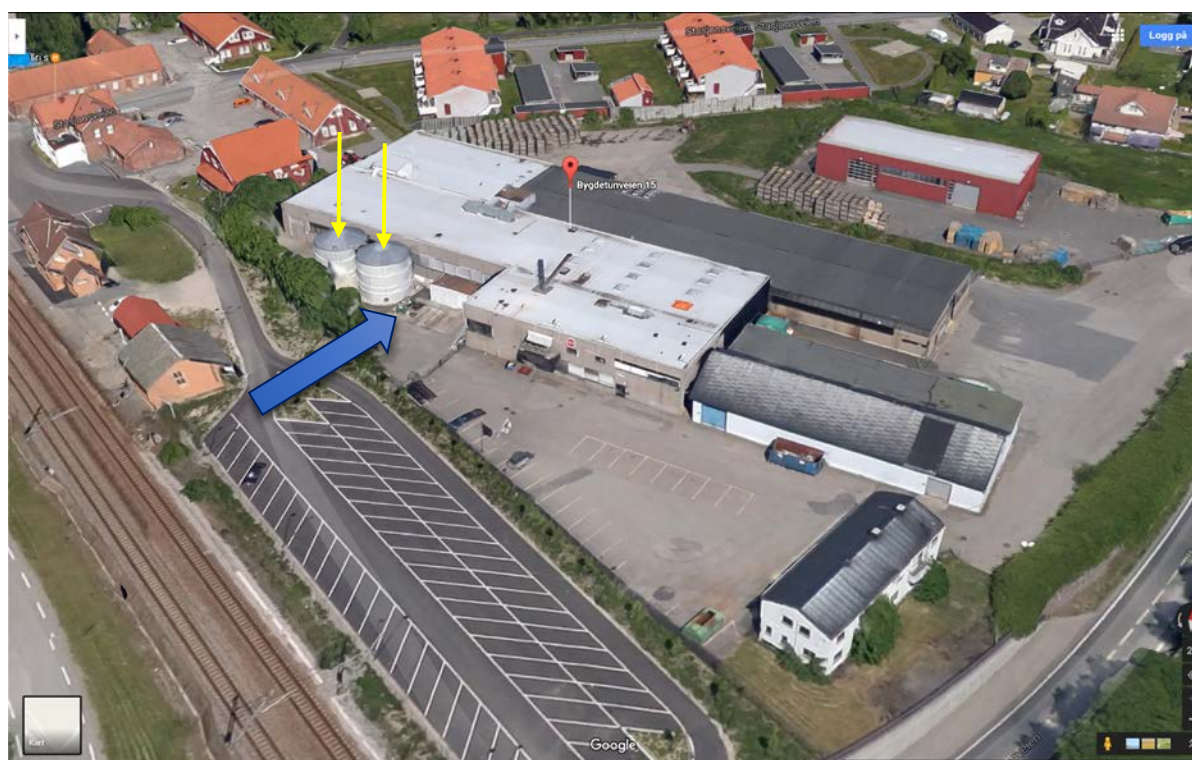
Figur 1.2 Oversiktsbildet over Norafabrikken. Gule piler indikerer buffertanker for vaskevannet. Blå pil indikerer containeren for det organiske avfallet, som hentes med jevne mellomrom. (Google Kartdata, 2017)
