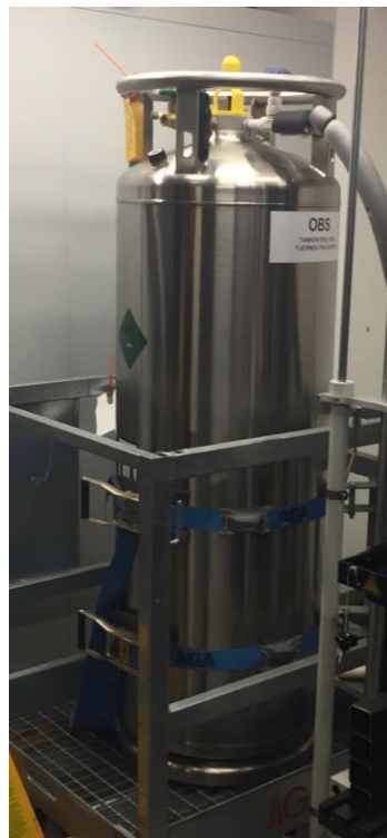
Figur 3-17 - En egen trykktank med flytende nitrogen brukes for å kjøle ned frysekammeret.
