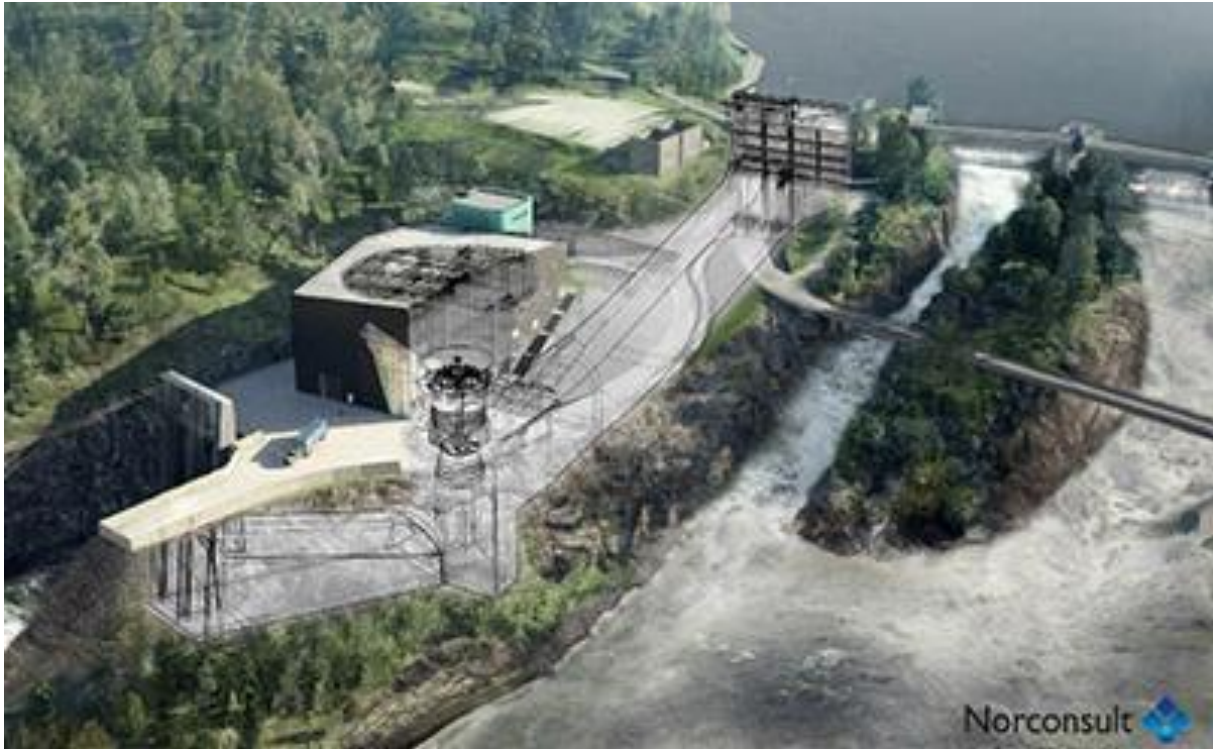
Figur 9 VAMMA kraftverk: eksisterende anlegg
