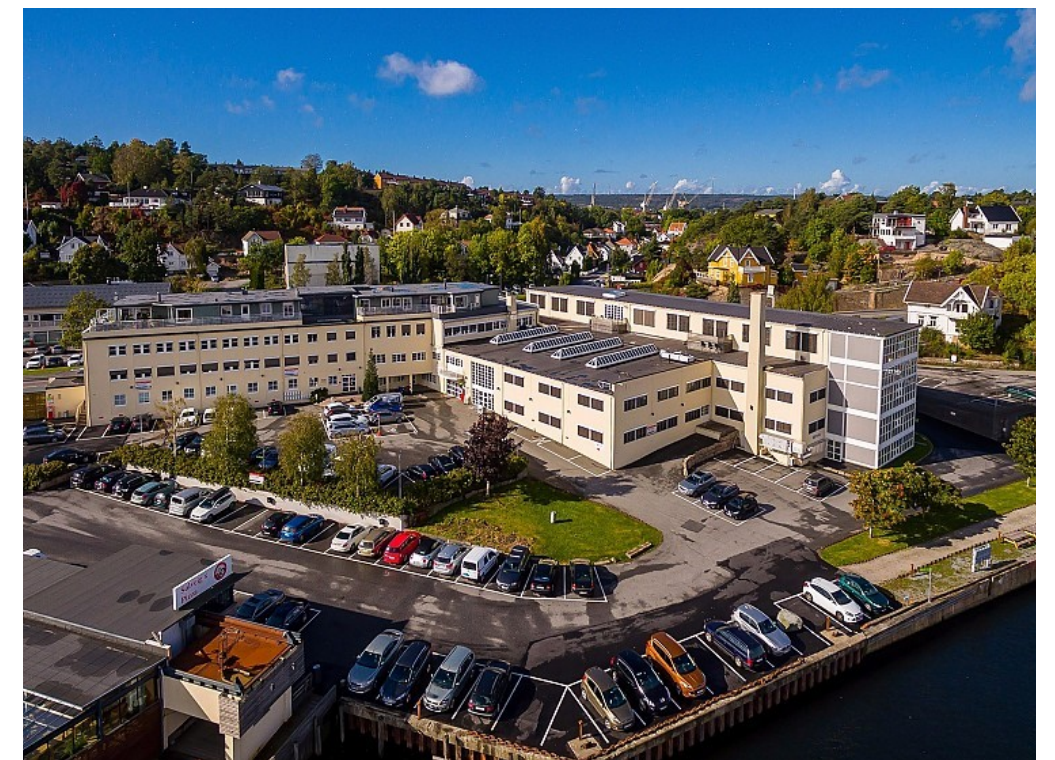
Foto 11: Glommen brygge mot nord-vest med verkstedshallen og kontorfløyen (Sorliebygg, 2016)
