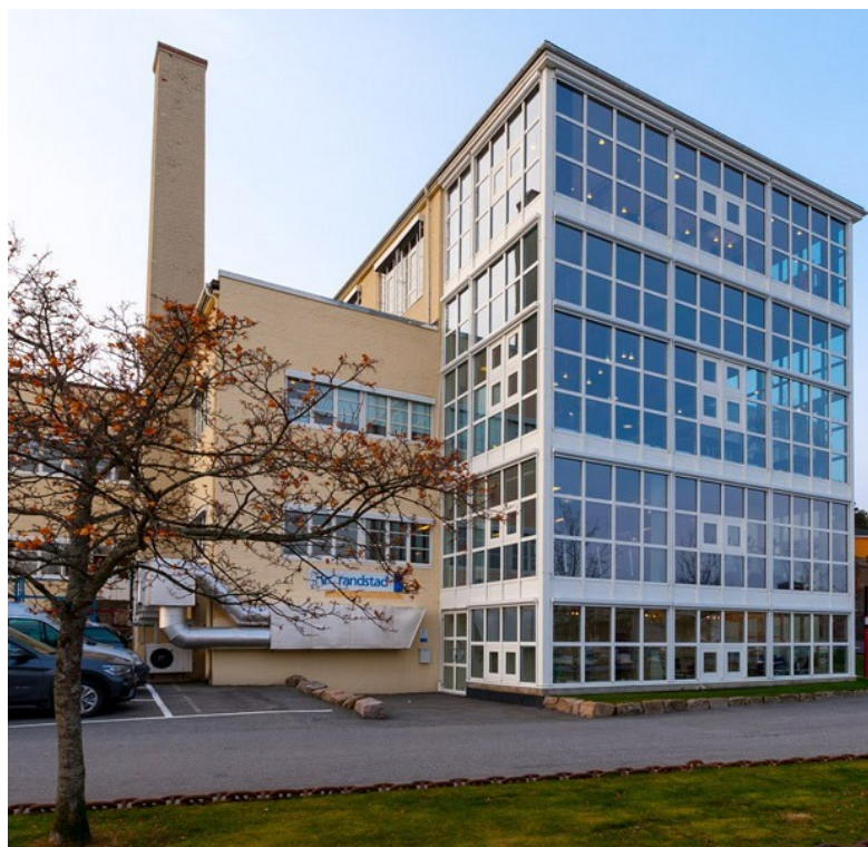
Foto 9: Glassfasade verkstedshall (Sorliebygg, 2016)
