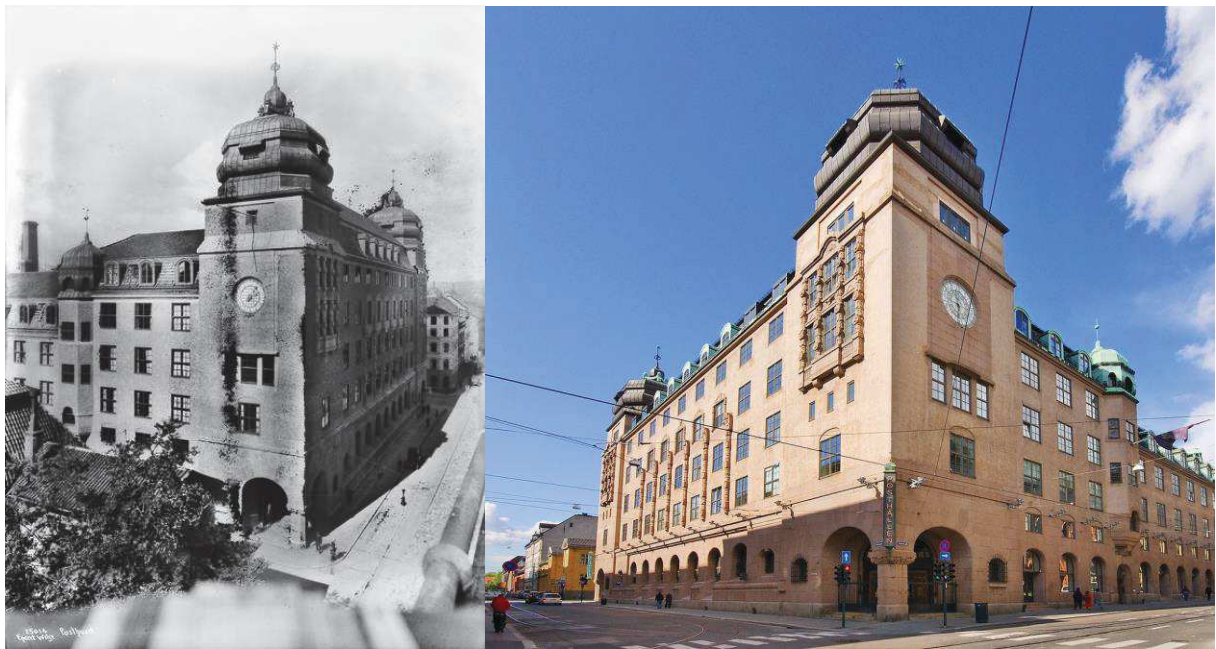
Bilde 7: Bildene viser bygningen før og etter konverteringen. Bildet til venstre er tatt i 1924 fra den tiden bygget ble brukt som hovedpostkontor (Oslobilder (2), 2017), mens bildet til høyre er fra etter konverteringen (Linstow, 2017)
