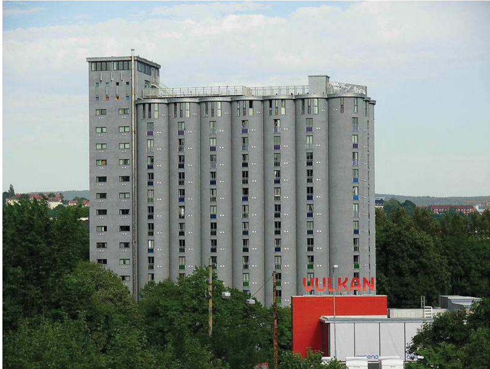
Bilde 2: Grunerløkka studenthus" er et eksempel på et industribyggelse som har blitt konvertert til boliger. Bygget ble bygget i 1953 som kornsilo, og ble i 2001 konvertert til studentboliger (wikipedia (1), 2017).
