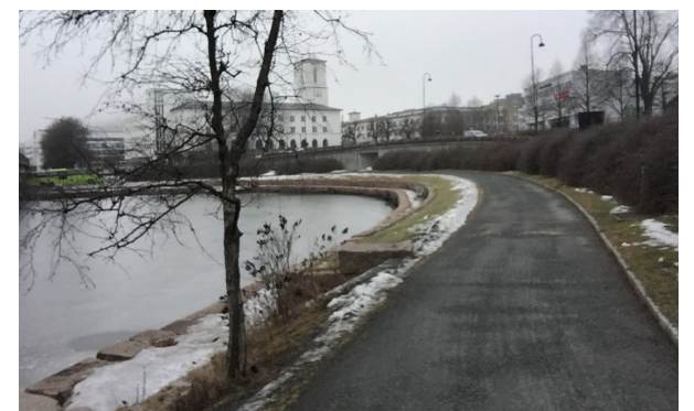
6. GANGVEI PÅ INNSIDEN AV E18
