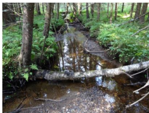
Figur 20. Alternativ D2 er en av flere alternativer som medfører at bekken Nesja, gytebekk og innløpsbekken til Rungstadvatnet, ville krysses med kulvert og må legges noe om. Tiltaket medfører et direkte inngrep i bekken, men det ble ansett som uproblematisk å anlegge kulvert som opprettholdt fiskevandring (Statens vegvesen 2013a).
