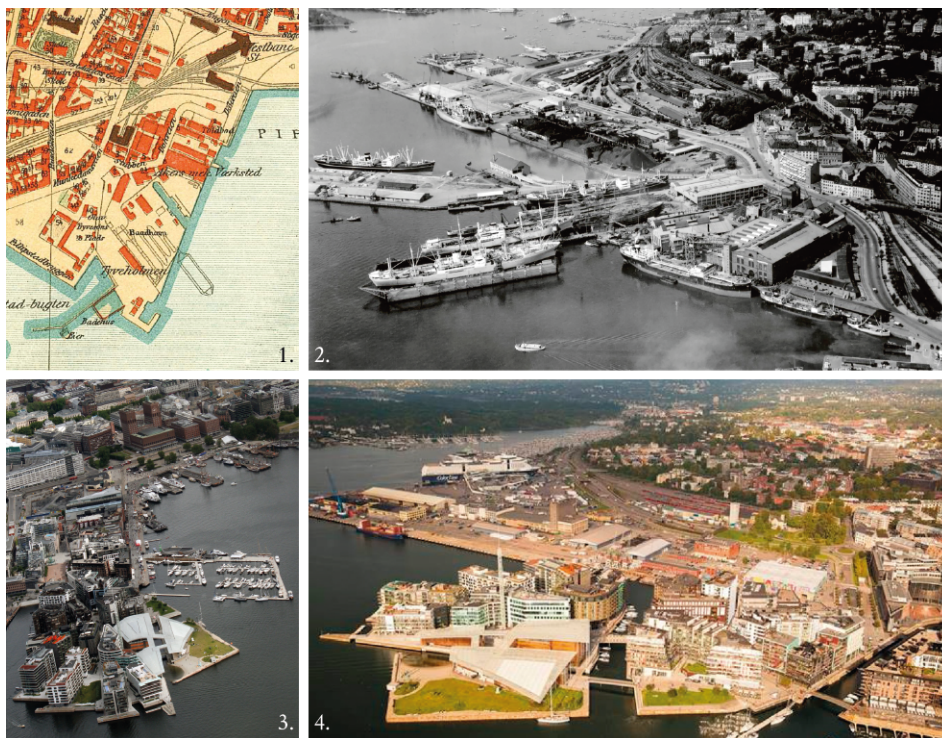
Figur 14: Illustrasjon av transformasjon av Tjuvholmen. Foto 1. Tjuvholmen og Holmen (nå Aker Brygge) i 1917 (Wikipedia, u.å), Foto 2. Tjuvholmen i 1958 (Rusdal, 2015), Foto 3. Flyfoto fra sør (Wikipedia, u.å), Foto 4. Tjuvholmen sett fra luften (Rusdal, 2015)
