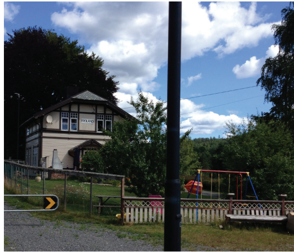
Figur 20 Froland stasjon (Sørlandsbanen). Kun en større, gruslagt parkeringsplass, ser ut til å være forbeholdt allmennheten ved Froland stasjon.
