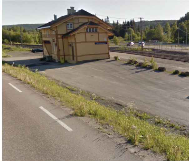
Figur 22 Grua stasjon, Gjøvikbanen. Førsteintrykket av stasjonen er grått, og lite trivelig. Hele den eldre stasjonsparken er fjernet, til fordel for parkeringsplasser.
