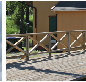
Figur 108 Gjerde, Haga stasjon (Strandberg, 2010)
