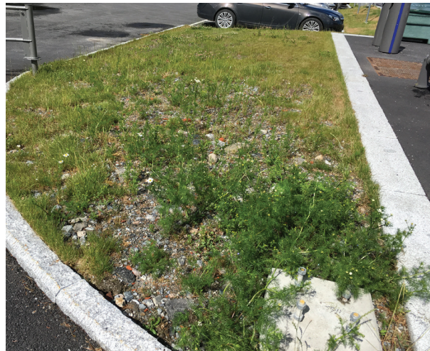
Figur 30 Tomter stasjon, Østfoldbanen. Rabatten har tynn vekst av gress. Det er tydelig at jorda inneholder mye grus og stein.
