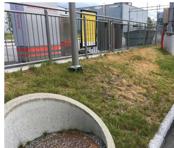
Figur 16 Spydeberg stasjon, Østfoldbanen. Gressbakken har blitt klippet med kantklipper. Større deler av gressarealet har gulnet grunnet tørke.
