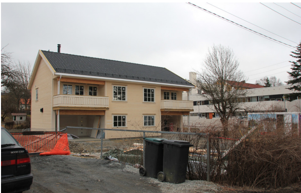
Figur 18: Bjerkealléen 9A - Gjenoppbygging etter brann.
