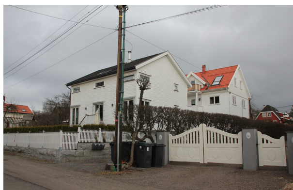
Figur 16: Kapellveien 11B – Et typisk eksempel på villahagefortetting der det fremste huset er opprettet i hagen til eksisterende enebolig og tomten delt opp i eierseksjoner. Rammetillatelse gitt i 2008.
