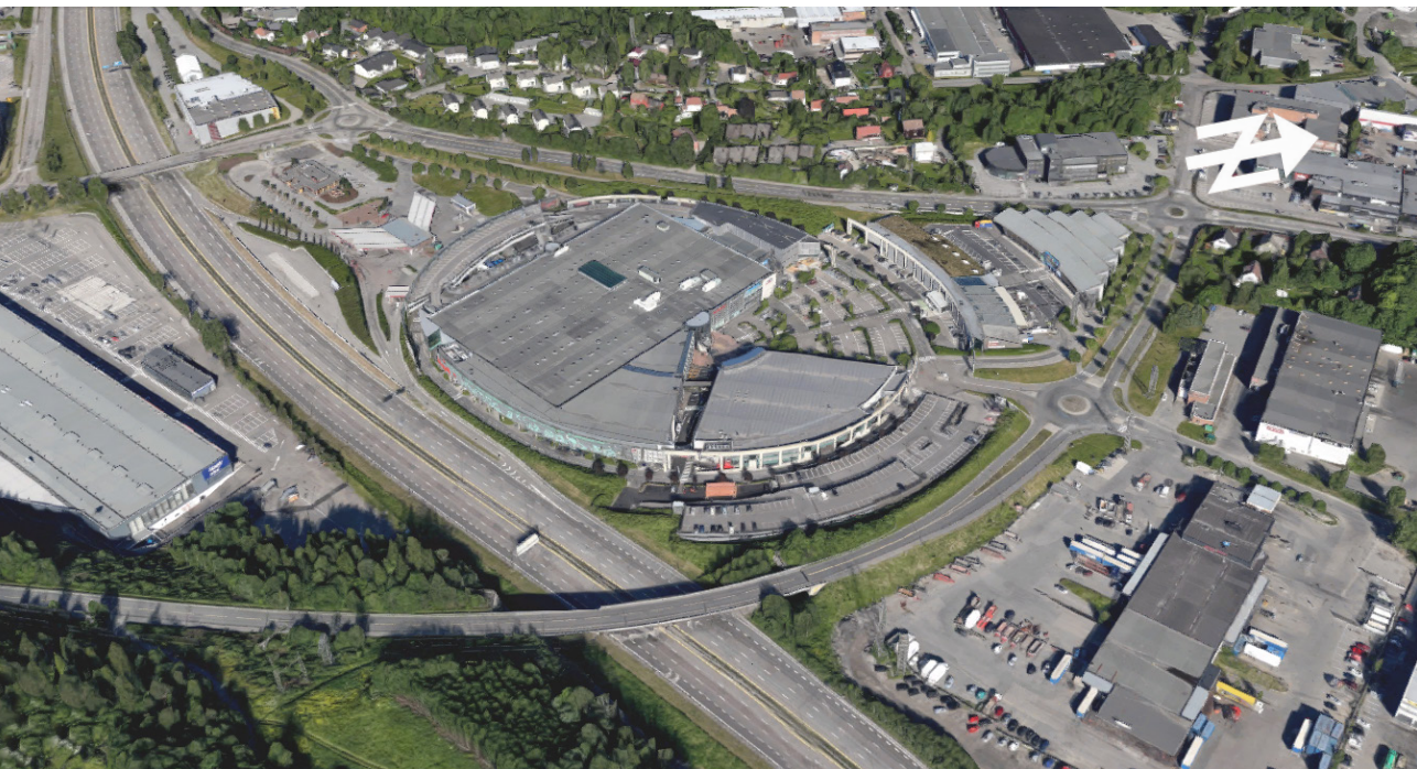
Alna Senter med E6 i forgrunnen og Strømsveien øverst, 2017. Nordpil øverst til høyre indikerer bildeorientering. Kilde: Google Earth
