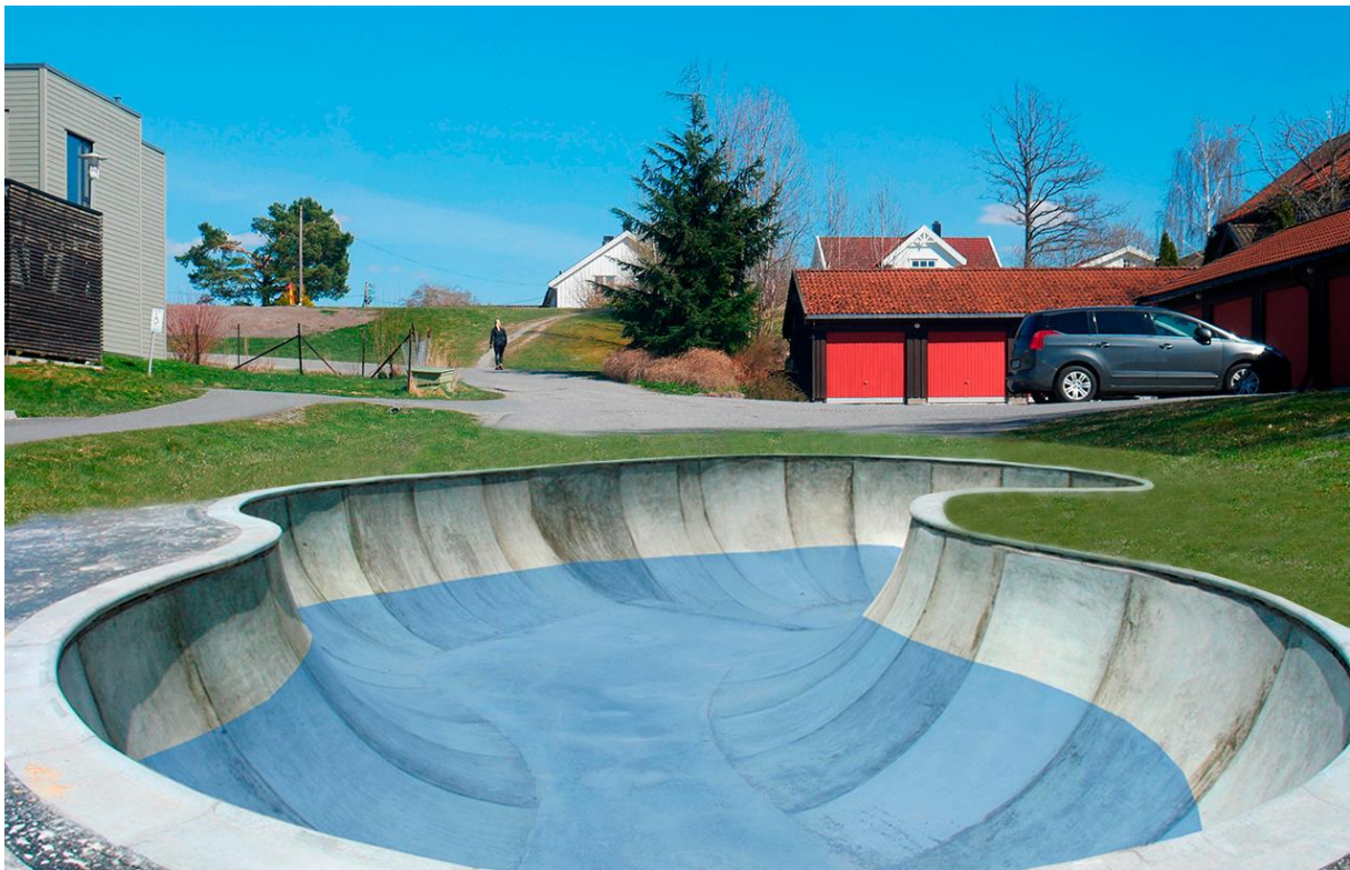
Figur 1: Bildet illustrer hvordan en skatepark kan bli brukt som fordrøyningsbasseng. (Kilde Jonathan Hay 2013 og Andreas Elders 2017, red. Andreas Elders).
