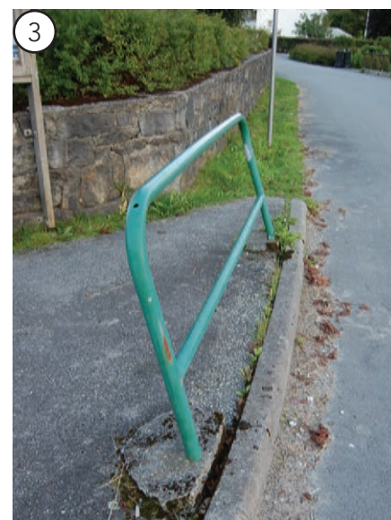
Fig. 3.039. Slike metallgjerder står langs E134 gjennom Etnesjøen.
