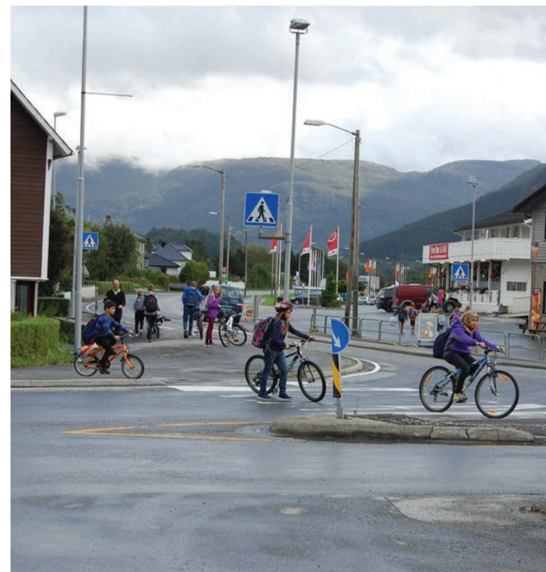
Fig. 3.020. Krysset Strondavegen/ E134 er en viktig skoleveg. Foto tatt i slutten av august 2016.
