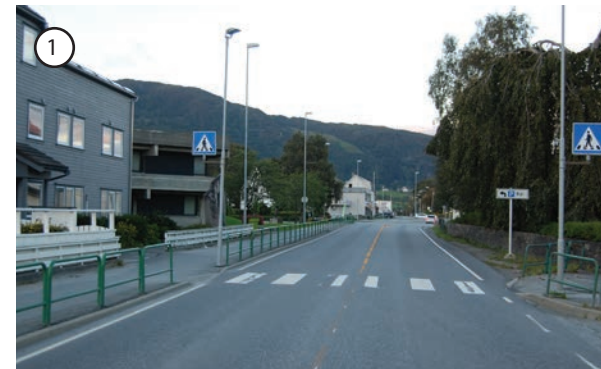
Fig. 3.046. Gangfelt som krysser E134 ved Fønix Hotel. Jevn overflate, ingen opphøyning.
