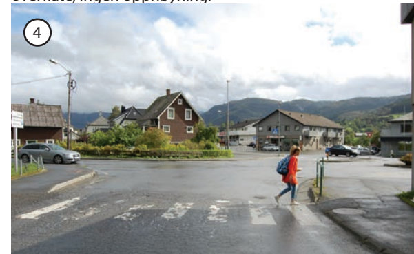
Fig. 3.048. Gangfelt som krysser vegen ned til Tongane. Dårlig oppmerking og høy fortauskant.
