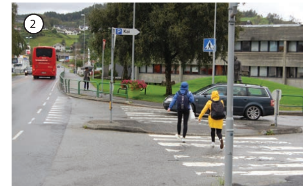
Fig. 3.047. Gangfelt som krysser Sjoarvegen ved E134. Høy midrabatt, ujevn overflate.
