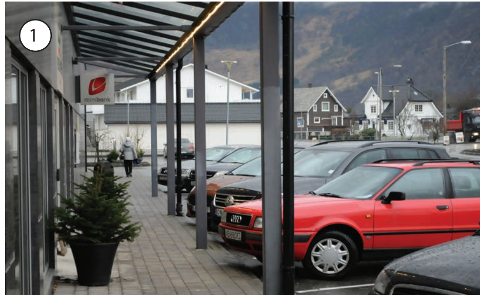
Fig. 3.054. Fortau under tak ved Etne senter.
