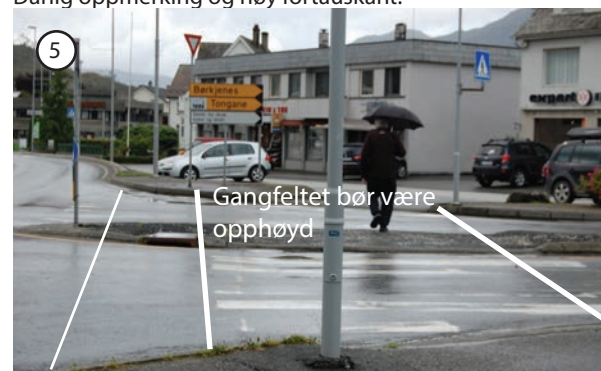
Fig. 4.030. Gangfelt som krysser Fv.34. Ujevn overflate og høy midtrabatt.
