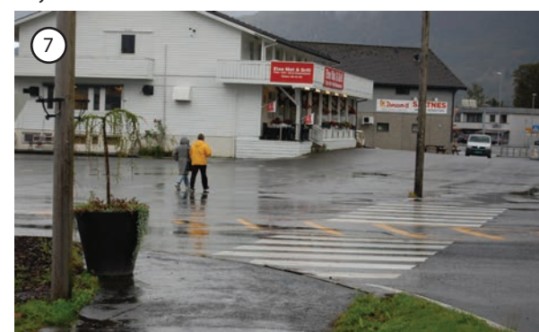
Fig. 3.052. Gangfelt ved innkjøring til Etne senter. Høy fortauskant i øst og forvirrende oppmerking.
