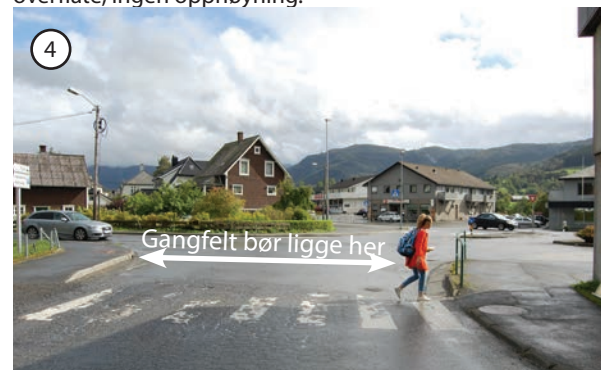
Fig. 4.028. Gangfelt som krysser vegen ned til Tongane. Dårlig oppmerking og høy fortauskant.
