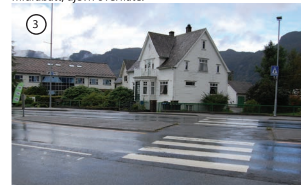
Fig. 3.049. Gangfelt som krysser E134. Jevn overflate, slakt hellende terrenn.
