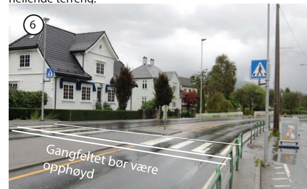
Fig. 4.031. Gangfelt som krysser E134 ved Etne senter
