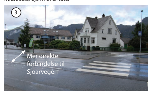
Fig. 4.029. Gangfelt som krysser E134. Jevn overflate, slakt hellende terrenq.
