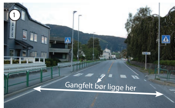
Fig. 4.026. Gangfelt som krysser E134 ved Fønix Hotel. Jevn overflate, ingen opphøyning.
