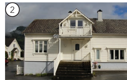
Fig. 2.092. Halvpassiv fasade, det gamle posthuset.
