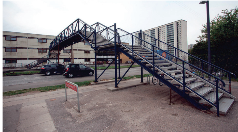
Fig. 4.013. Gangbru over veien gir lang omveg for gående og er bygd for bilen. Fra Danmark.
