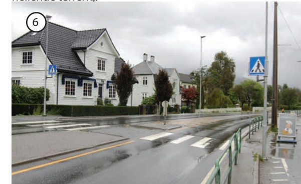
Fig. 3.051. Gangfelt som krysser E134 ved Etne senter
