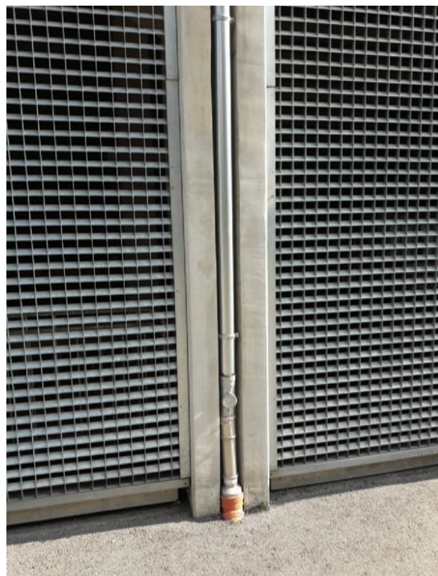
Figur 3.68: Takvann fra tribunene ledes direkte ned i kommunalt rørsystem.
