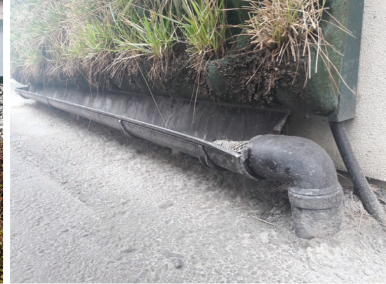
Figurgruppe 2.57: Tekniske installasjoner knyttet til drenering og vanningsystemet ved BIRs bossterminal i Jekteviken, Bergen.
