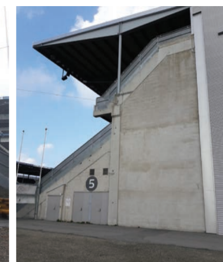
Figur 3.74: Betongflate på sørsiden av østtribunen.
