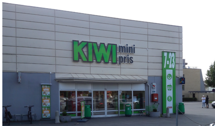
Figur 3.59: Fasaden på næringsbygget ved nordtribunen.
