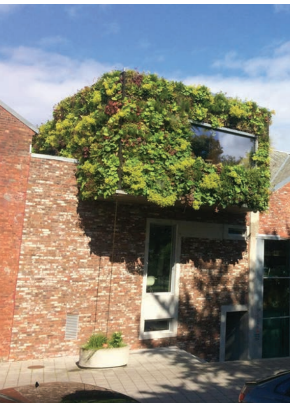
Figur 2.48: Oransjeriet i Stavanger. Grønn vegg tilknyttet kontoret til Bark Arkitekter. Foto: Bergknapp AS
