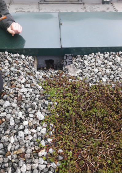
Figurgruppe 2.57: Tekniske installasjoner knyttet til drenering og vanningsystemet ved BIRs bossterminal i Jekteviken, Bergen.
