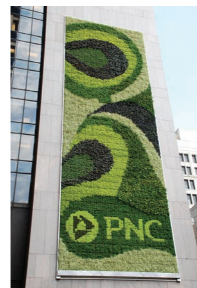
Figur 4.42: Fasade på PNC-bygget i Pittsburgh, USA. Foto: PNC Bank
