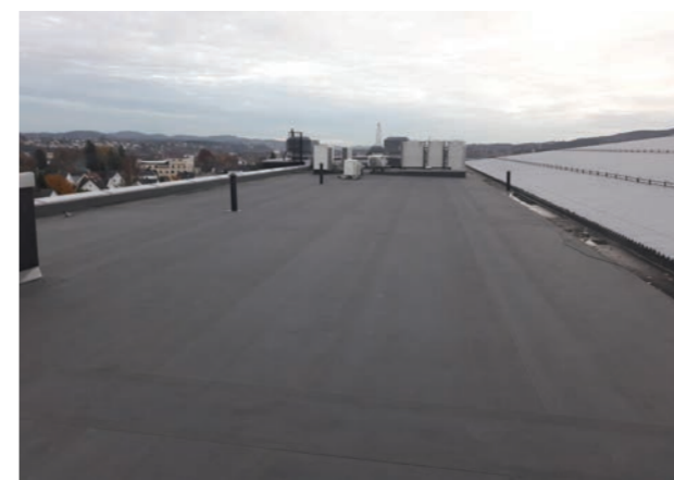
Figur 3.83: Takpapp over takkonstruksjon på østtribunen. I bakgrunnen ser man flere tekniske elementer som må tas hensyn til.
