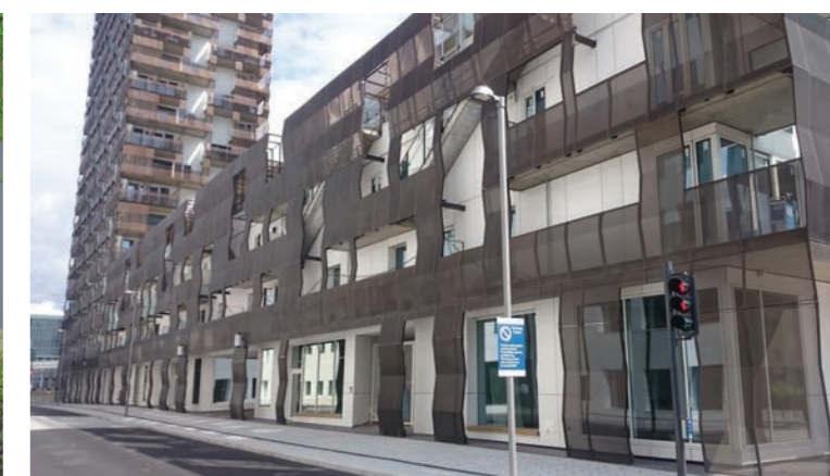
Figur 4.57: Fasade med et stålespalier for klatreplanter. Bygg i Barcode, Oslo, tegnet av Lund Hagem Arkitekter. Foto: Michal Soucek
