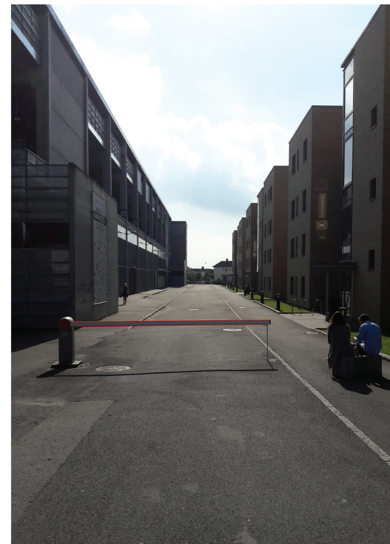
Figur 3.40: Gatelivet mellom vesttribunen og Stadion Terrasse borettslag.
