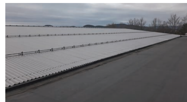
Figur 3.82: Aluminiumstak fra østtribunen. Samme taktype finnes over vest- og sørtribunen.
