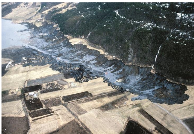
Figur 6: Rissaraset i 1978. Kilde: Teknisk ukeblad
