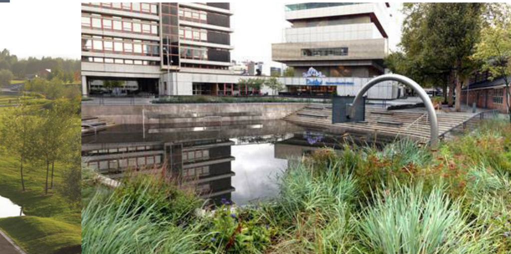
Fig. 2.3.6 Flerfunksjonell fordrøyningssjø. Waterplein Bentheimplein, Rotterdam, Nederland. (Foto: www.landarchs.com)
