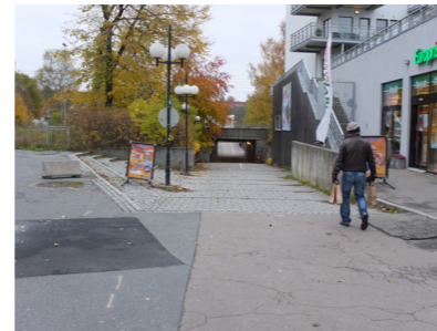
Fig. 3.1.17 Gang og sykkel tunnel under jernbanen
