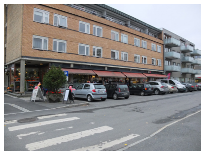
Fig. 3.1.3 Moerveien ved Skoleveien
