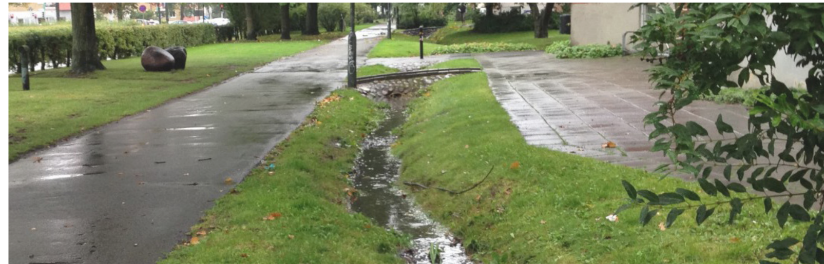
Figur 1.18 Åpen overvannshåndtering i Malmö. (www.swedenwaterresearch.se)
