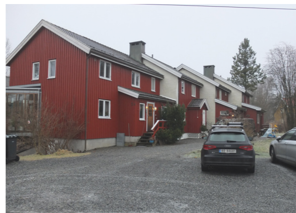
Fig. 2.2.18 Rekkehusbebyggelse i Søråsteigen boligfelt.
