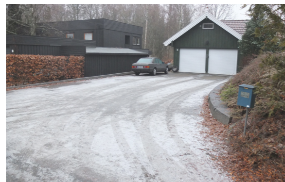
Fig. 2.2.27 Privatbolig Søråsteigen. Foto viser en stor oppstillingsplass med tett flate som tar emot mye overvann på den private tomten. Privatbolig Søråsteigen.
