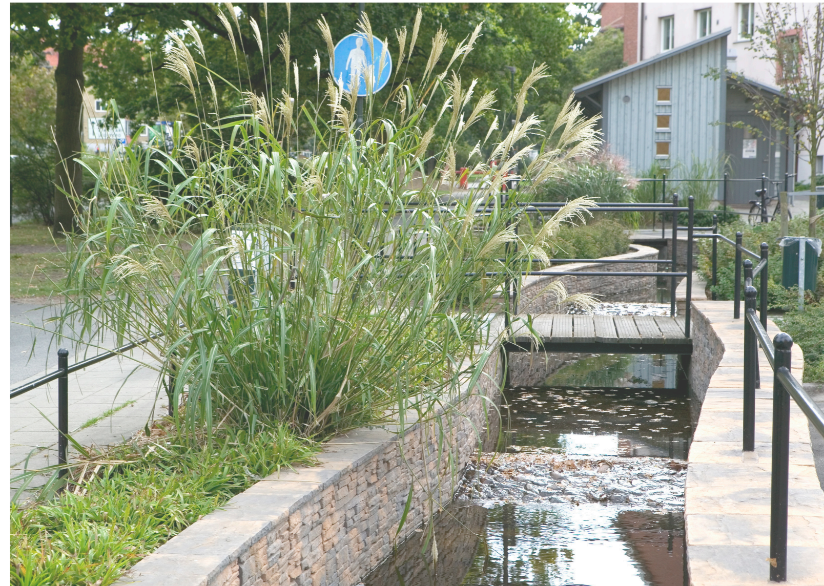
Fig. 1.4. Overvannskanal i Augustenborg i Malmö. (Foto: urbanreport.wordpress.com)
