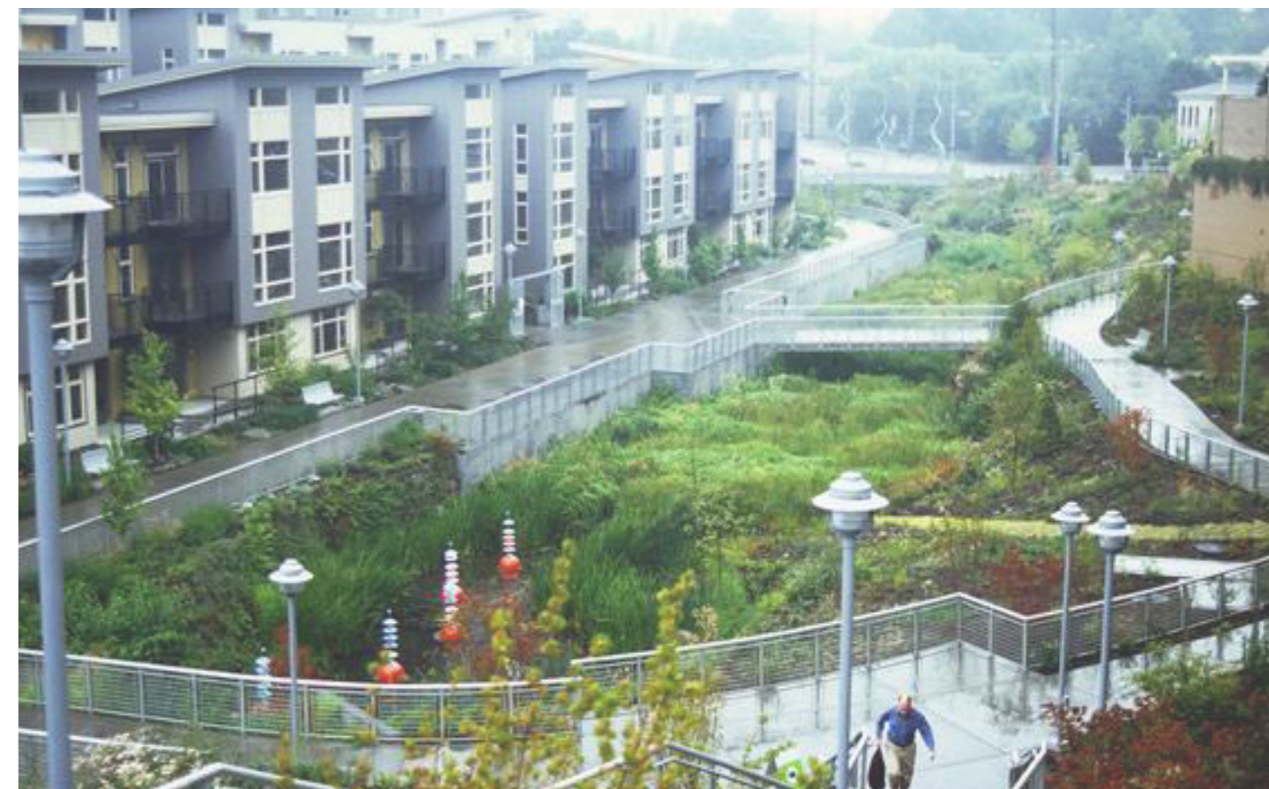
Figur 1.15 Blågrønn struktur med overvannshåndtering og åpent bekk, Thornton Creek water quality channel i Northgate, Seattle. (foto: www.gaynorinc.com)
