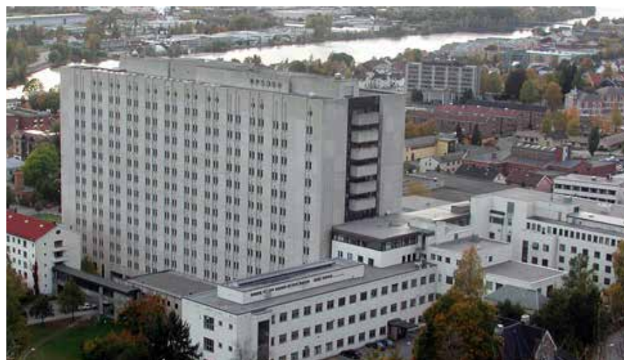
Bilde 2.11. Eksisterende Drammen sykehus.
