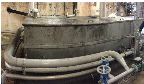
Figur 15: Bilde av blandekammeret fra rensanlegget på NORA
