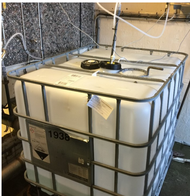
Figur 13: Styring av dosering av lut
