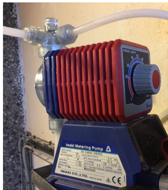
Figur 14: Doseringspumpen til lut
