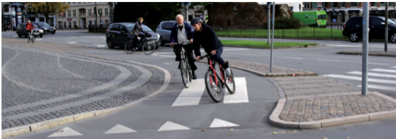
Bilde 14: Filterfelt som går til høyere rett før kryss i København (Jensen et al. 2013).
