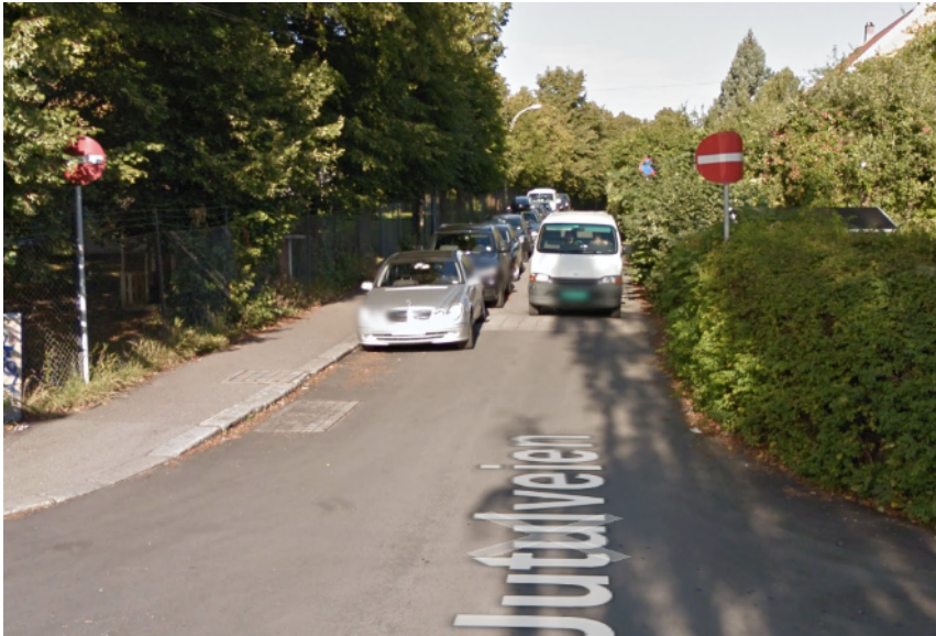
Bilde 21: Mangel på motstrøms sykkelfelt i enveiskjørt gate, Jutulveien, fra syklistrute 1 (Google Street View).
