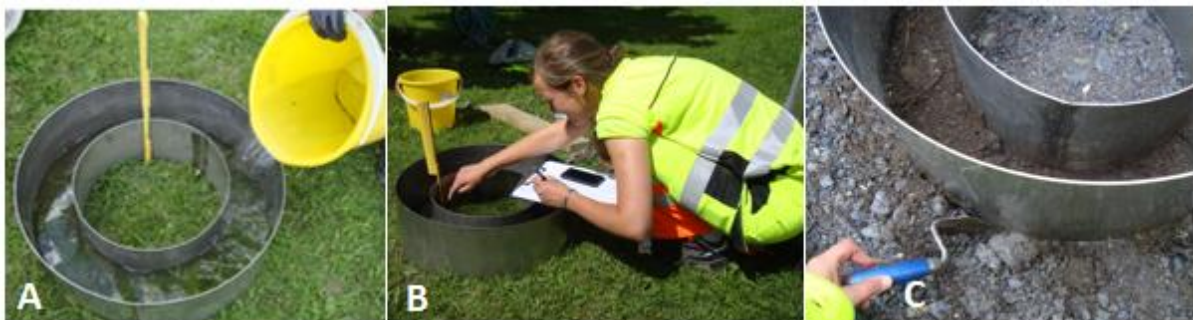
Figur 15: Forsøk med dobbelring-infiltrometer. Ytre og indre ring fylles samtidig med vann etter at ringene er banket 5-10 cm ned i bakken (bilde A). Vannhøyde (indre ring) og tilhørende tid noteres etter hvert som vannet infiltrerer (bilde B). På byggegrunn er det utfordringer med å få dobbelringen ned i bakken, men en murspade eller kniv er et fint verktøy for å fjerne stein som ligger i veien, før ringene bankes ned (bilde C). Foto: Elisabeth Blom Solheim og Merete Stange Sørum.
