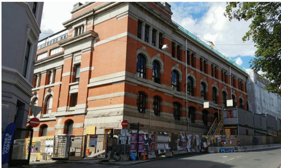
Figur 7. Tidligere Statens håndverks- og kunstindustriskole i Oslo sentrum er totalrehabilitert. Fra og med høsten 2015 er dette nye Edvard Munch videregående skole. (Foto: E.M. Lefdal)
