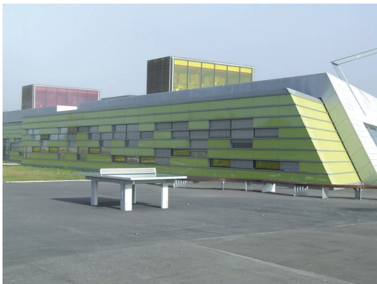
Figur 11. Gjerdrum ungdomsskole i Akershus fikk Statens byggeskikkpris i 2010 (Foto: E.M.Lefdal).
