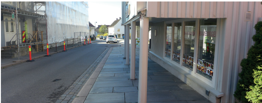
Figur 166 - her er det for lavt til at de fleste kan gå under
