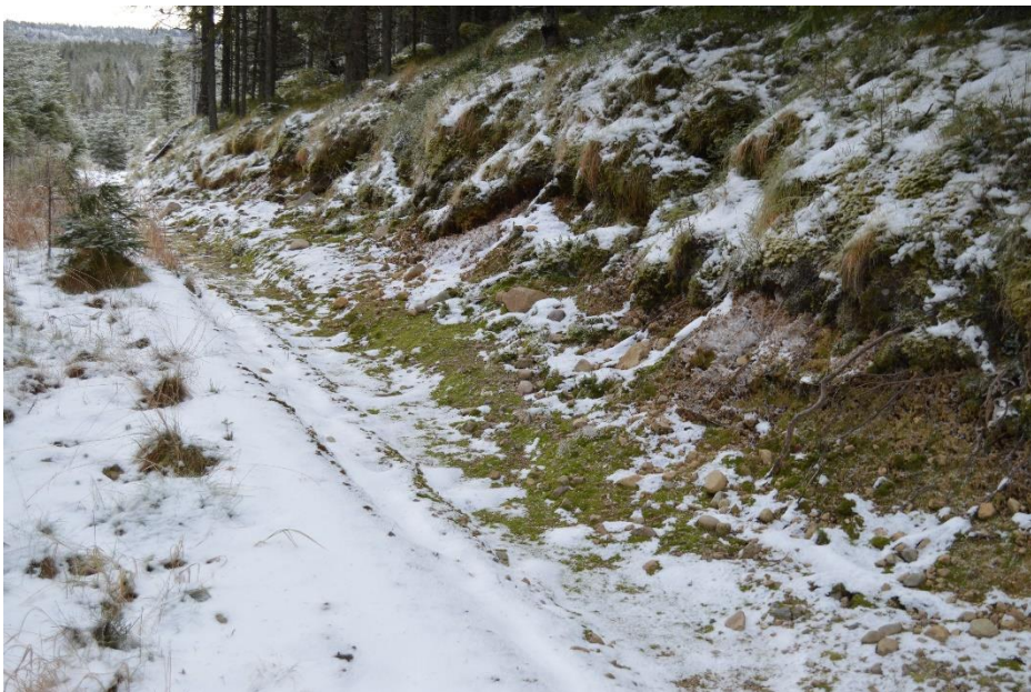
Bilde 2: Sidehellingsproblematikk blir forhindret ved bruk av gravemaskin. Foto: Torkjell Dyrdal
