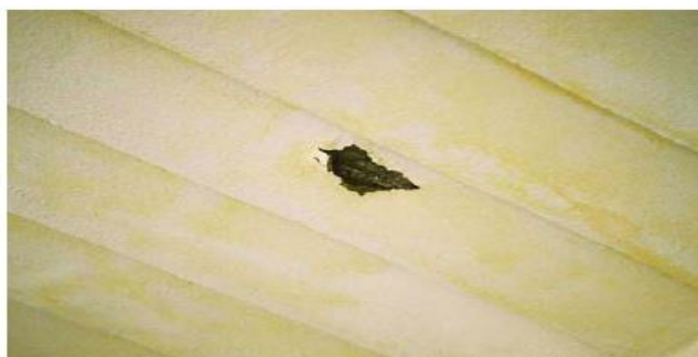
Figur 43: Misfarging og tegn til malingsavflassing på realkalisert flate. [23]
