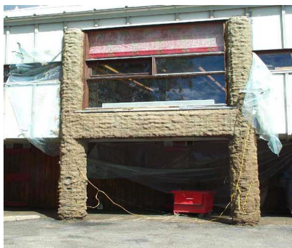
Figur 34: Elektrokjemisk realkalisering i praksis. [23]
