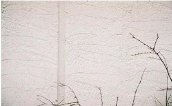
Figur 45: Spor i overflaten etter malingsfjerning. [23]
