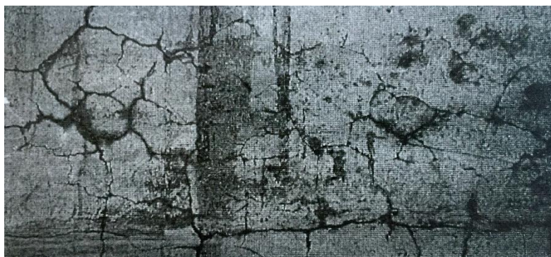
Figur 20: Typisk overflateriss fra alkalireaksjoner. [15]
