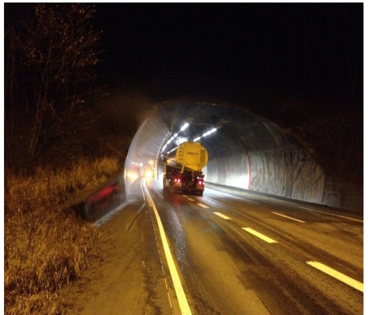
Figur 3-2: Vasking av Nordbytunnelen den 01.12.16. Vasket av Veidrift AS. (Foto: Arve Heistad)
