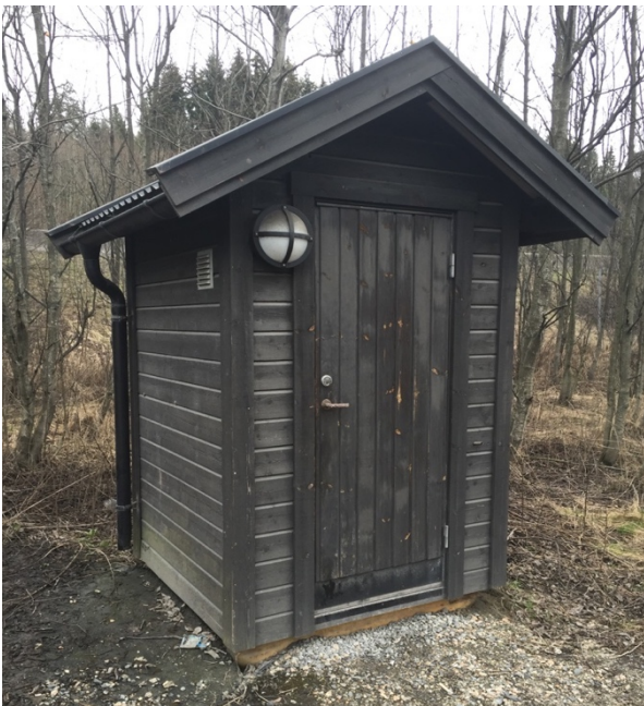
Figur 3-3: Pumpehuset tilhørende Vassum rensebasseng ved Nordbytunnelen. (Foto: Gunhild Nersten)
